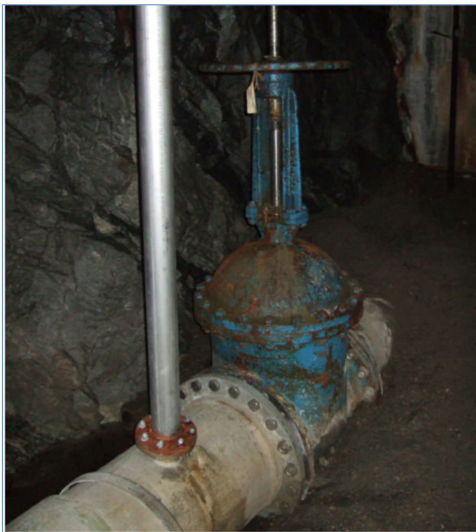
Figur 4.3: Tappeventil for tverrslagsport ved Steinhushaugseter [11]
