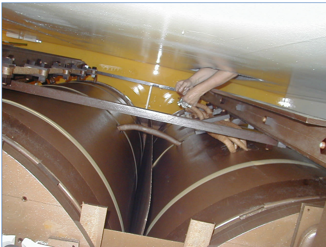
Figur 4.11: Forbikobling av omkobler i hovedtransformator [10]
