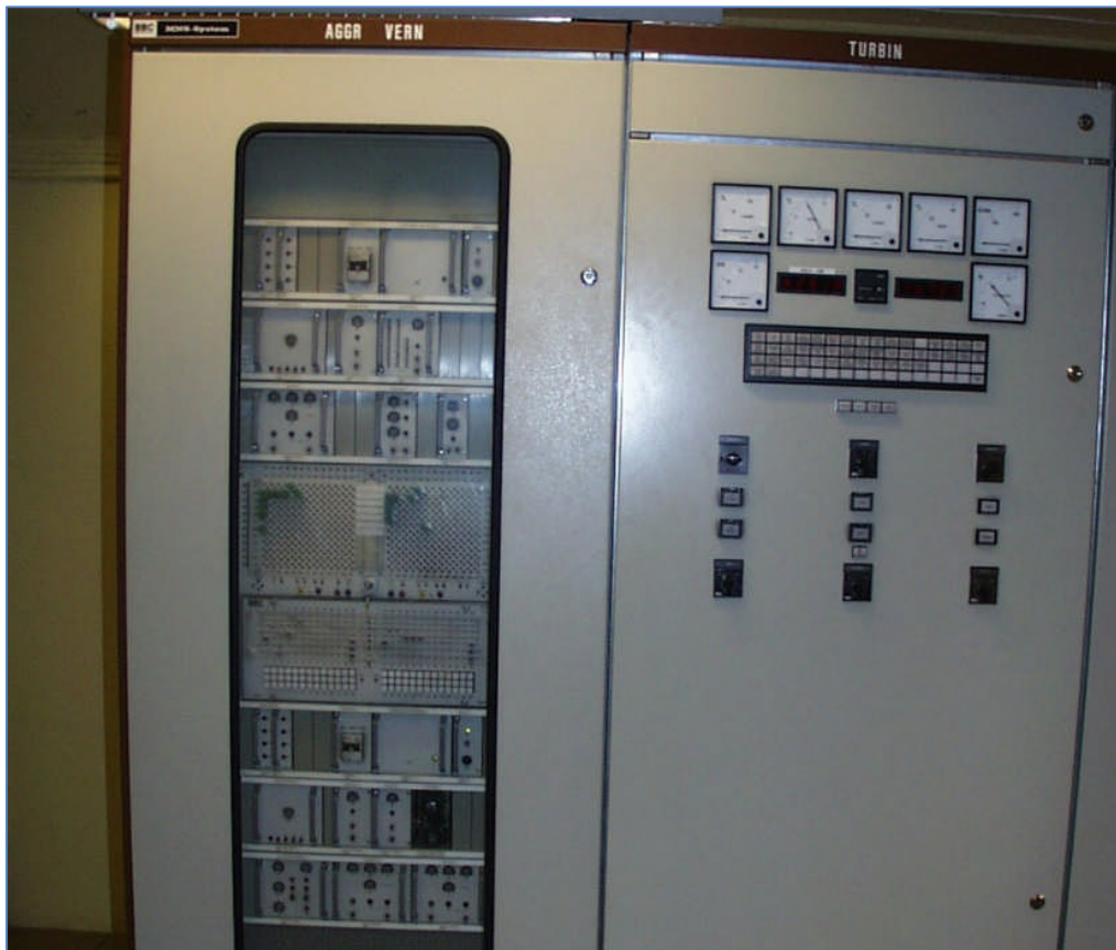
Figur 7.2: GSX5e elektronisk generatorvern i Kvittingen kraftverk
