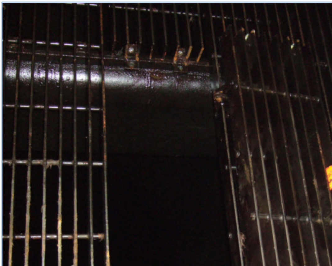
Figur 4.5: Finvaregrind mellom tunnel og trykksjakt mot Kvittingen kraftstasjon [11]
