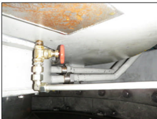
Øvre lager sett nedenfra
