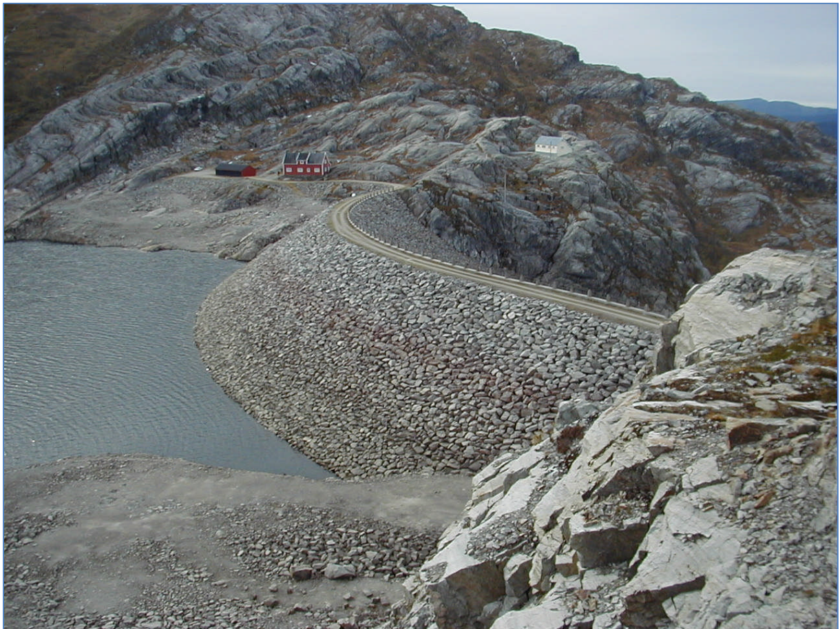
Figur 5.2: Steinfyllingsdam for Svartevatn (inntaksmagasin for Kvittingen kraftverk) [10]
