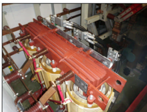
Tørrisolert magnetiseringstrafo
