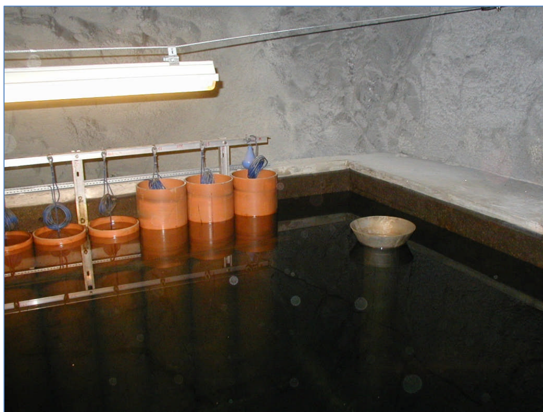
Figur 8.3: Kjølevannstank i Kvittingen kraftstasjon med flottører og overløp [10]
