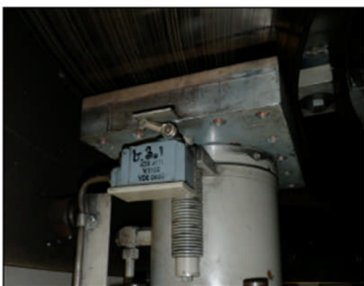
En av fire bremseklosser og bremsering
