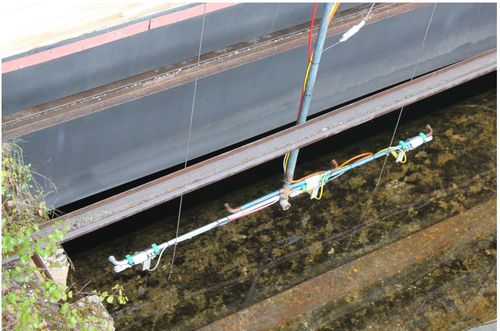
Figur E.1: Ene målerammen ferdig montert.
