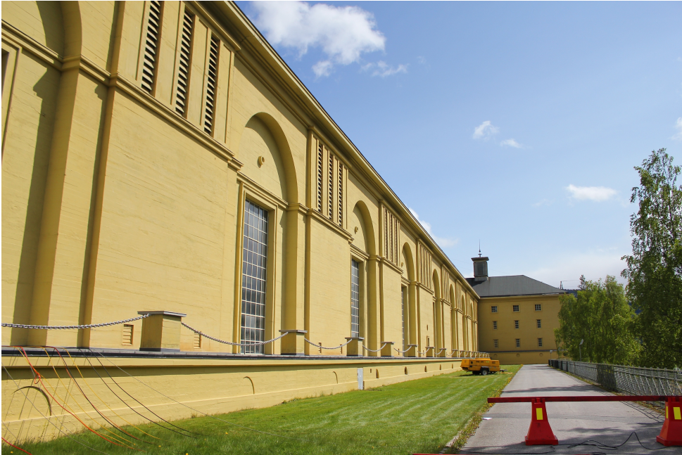
Figur 1.1: Kraftstasjonen Nore I.
