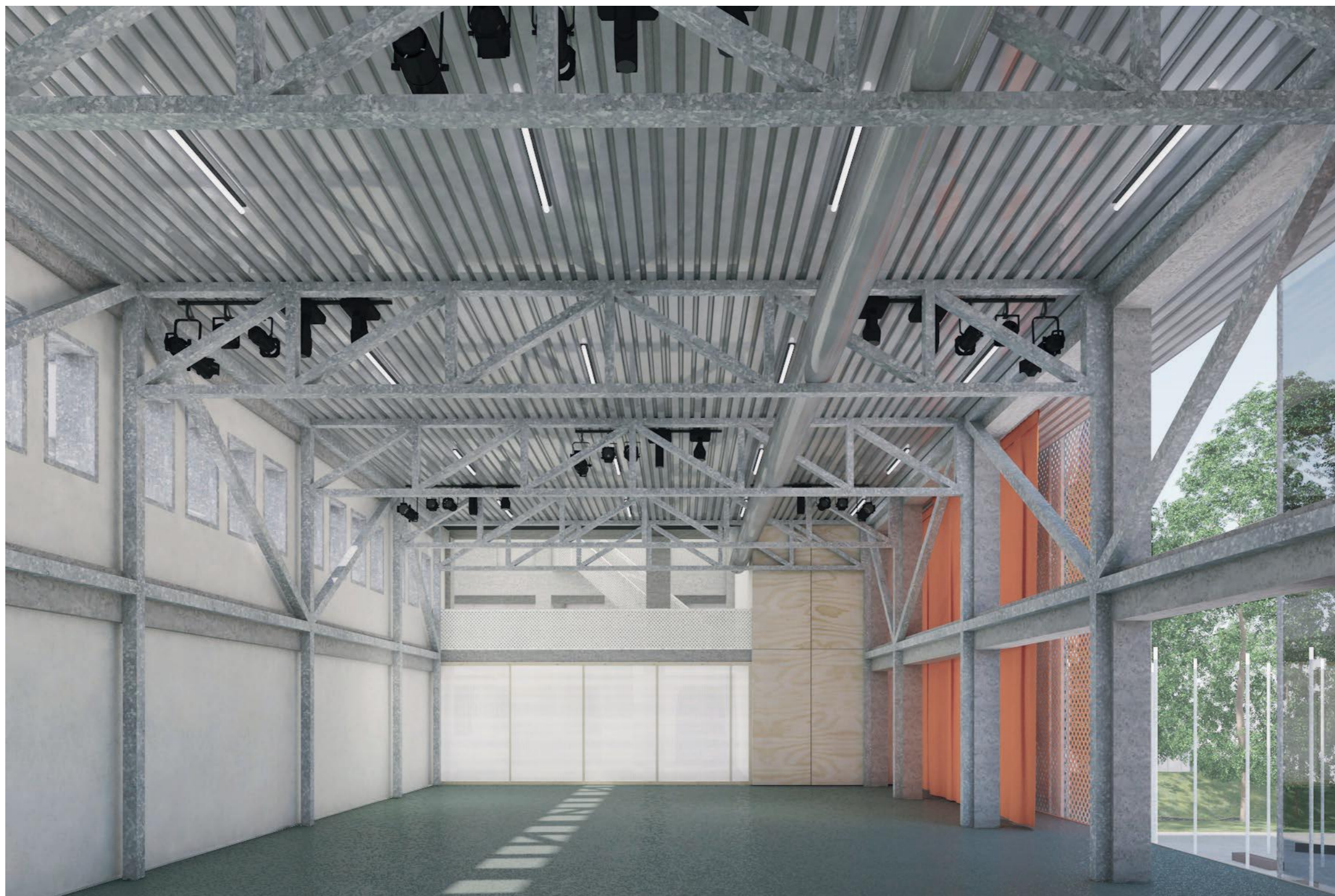
Storsalen. Det største øvingsrommet. Henvender seg mot parken og amfiet mot nord med store skyvefelt i glass, skjermplater og gardin. Eksisterende dekke fjernes, og ny sekundærkonstruksjon gjør det store rommet mulig.
