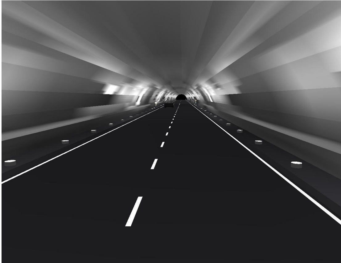
Figur 7.17: Armaturer montert vannrett i veikanten, komplett tunnel dekket med hvite plater:
