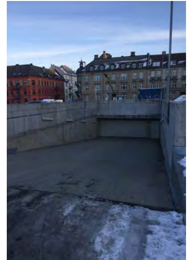
Nedkjøring garasje mellom Elgesetergate 16 og 18
