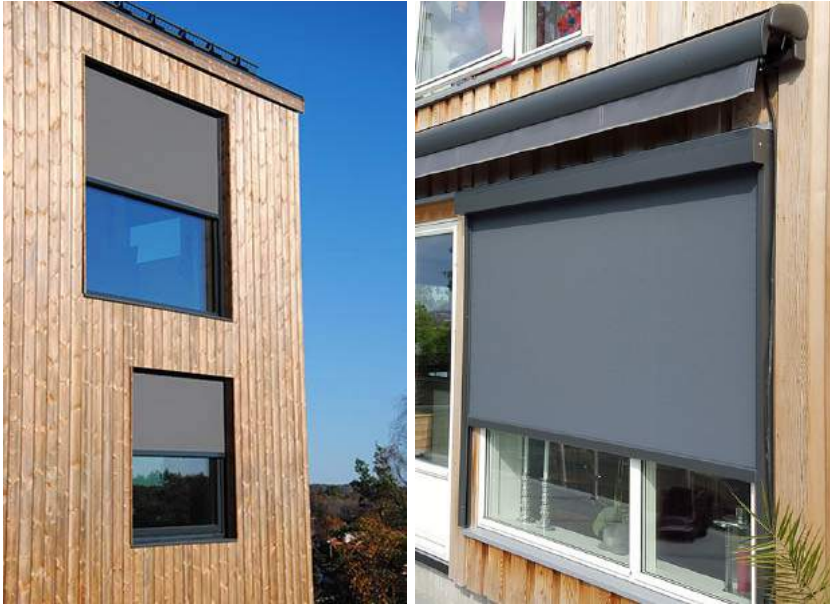
Utvendig solskjerming for vinduene mot sør. Viktig å ha skjermen ute - med innvendig solskjerm vil varmen komme inn og overoppheting vil bli et problem.
