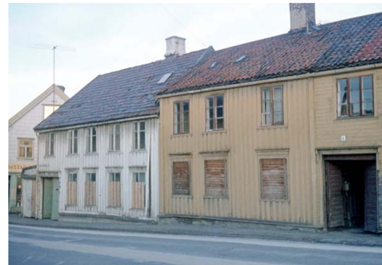
Lillegårdsbakken 2-4 før rivning
