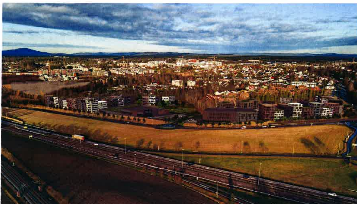
Bilde: Utviklingen av Jessheim, Jessheim Syd nærmest. Stor nytt prosjekt, som skal bli en ny bydel i Jessheim. Bak ser man alle kranene som er med på bygge andre boligprosjekter. (foto: Conceptor Bolig)
