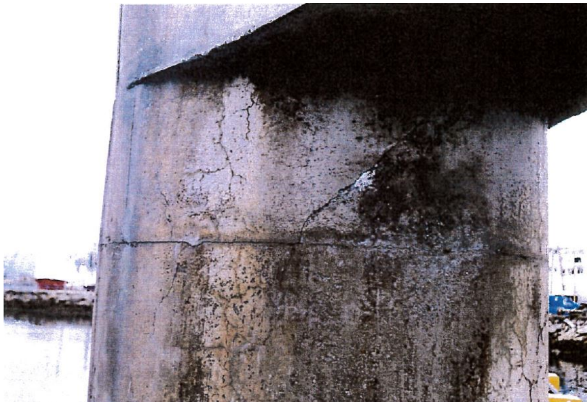
Figur 5.2: Skråriss i søyle under tverrbjelke [4]
