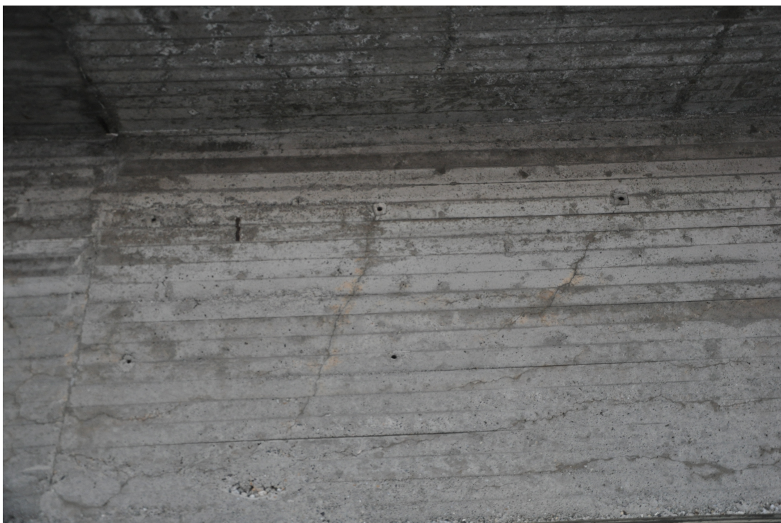
Figur 5.7: Skråriss i bjelken
