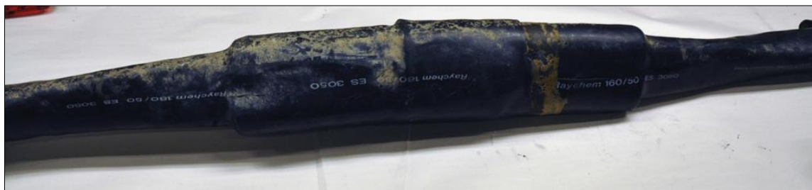
Figur 3-1: En av de utskiftede kabelskjøtene, før klargjøring for forsøk i laboratoriet.
