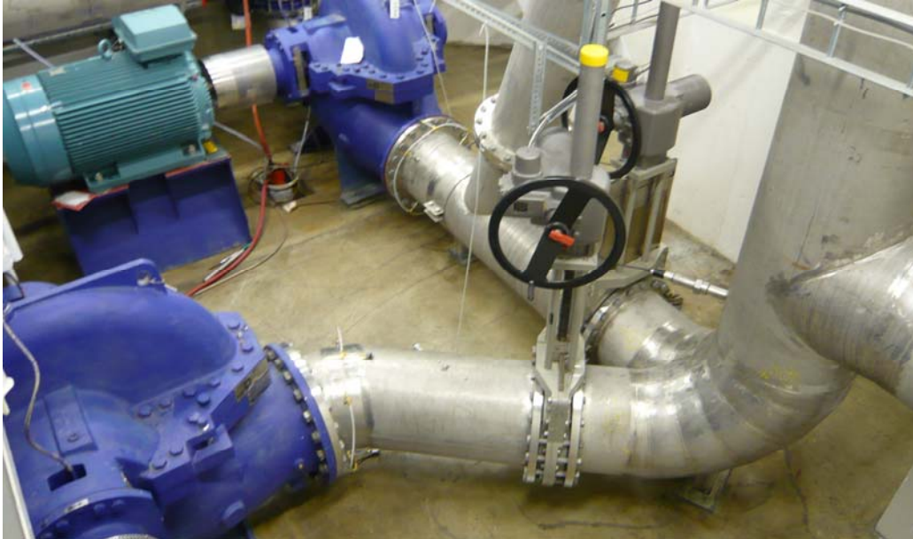
Figur 5-2, plassering av trykkuttak på innløpssiden av pumpene
