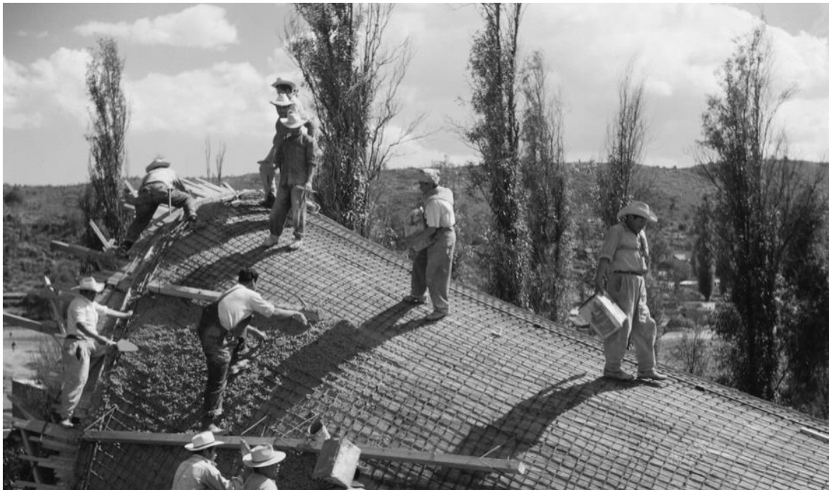
Figur 1-4: Byggingen av Los Manantiales av Félix Candela. Hentet fra: https://www.curbed.com/2018/1/25/16932400/felix-candela-architect-concrete-los-manantiales
