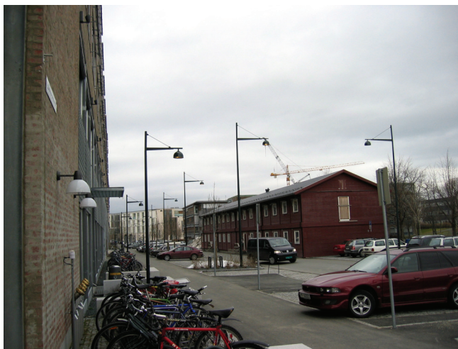
Figur 13-18: Lysmaster med induksjonslamper
