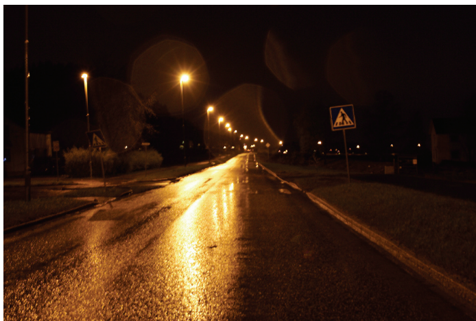
Figur 16-16: Veistrekning i Jonsvannsveien, vått dekke
