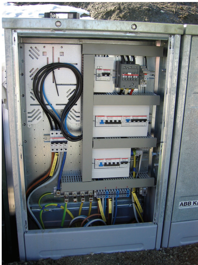
Figur 13-16: Tennskapet i veilyskursen, TN-S system
