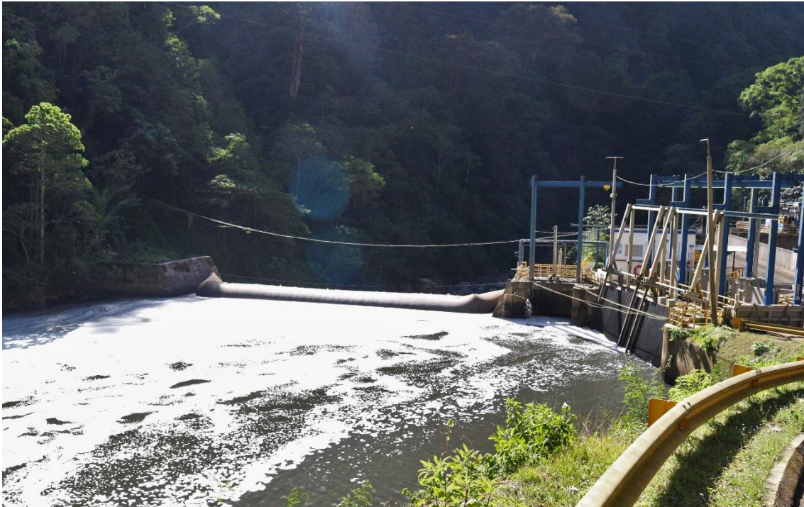
Figure 5.1 El Canadá HPP headworks.
