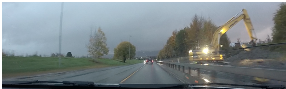
Figur 6.4: Svak innsnevring av kjørebanelen forbi busstoppene på Bjørndalstoppen grunna anleggsarbeid.
