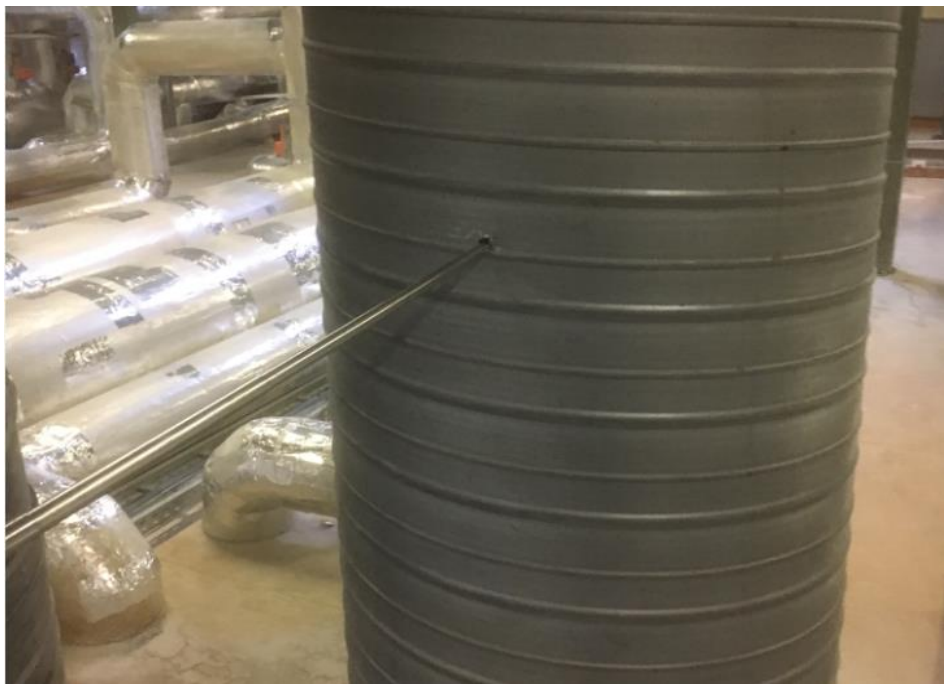
Figur 24 Måling av luftmengde i avkastkanal
