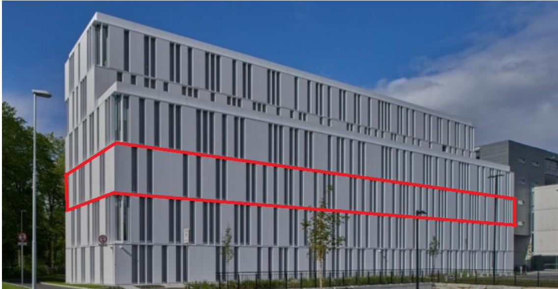
Figur 17 - Fasade mot parkering (Sør-vest). Rød markering viser 3. etasje der målingene ble utført [65]
