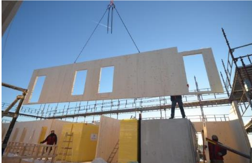
Figur 5: Montasje av veggelement i CLT 15
