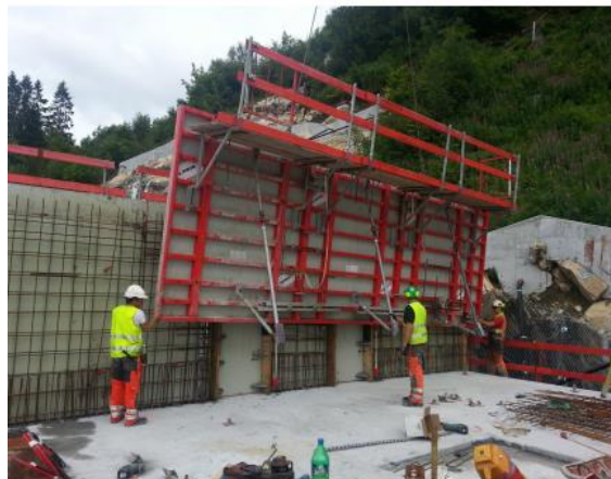
Figur 4: Forskaling for plastøpt betong (Jacobsen, 2014)
