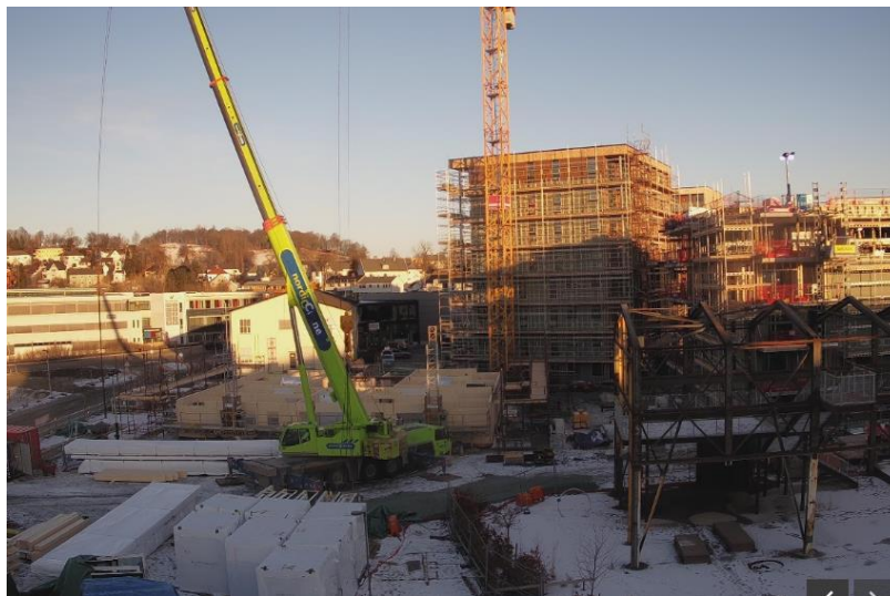
Figur 6: Montasje av CLT på byggeplassen på Lilleby
