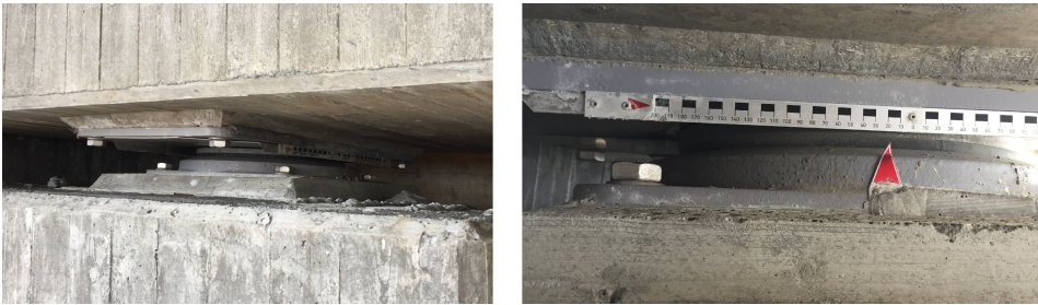
Figur 10.1: Lager akse 6 i Dolmsundbrua
