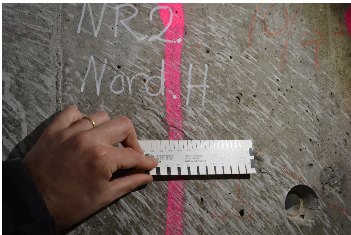
Figur 6.9: Skråriss nær feltmidte
