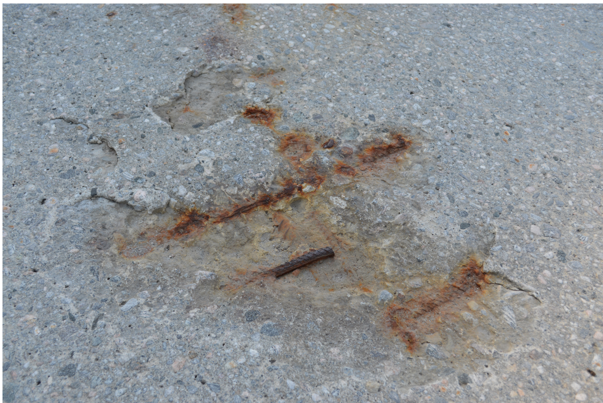
Figur 6.2: Synlig tverr- og lengdearmering i brudekket
