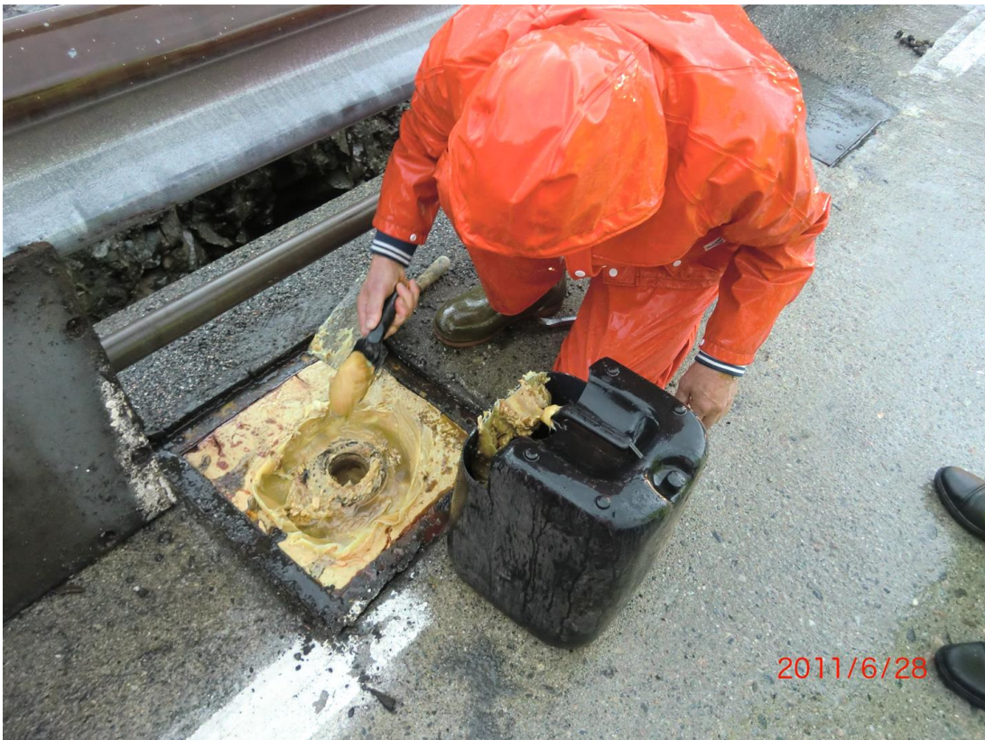
Figur 6.14: Fjellkabler innsatt med fett
