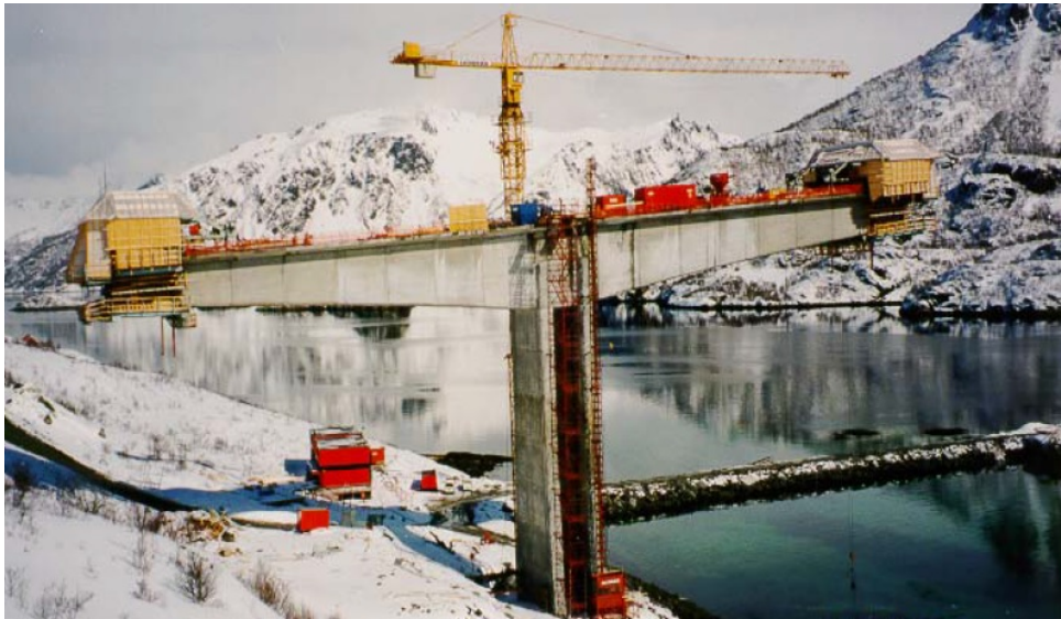
Figur 3.2: Balansert utbygging med forskalingsvogner [5]
