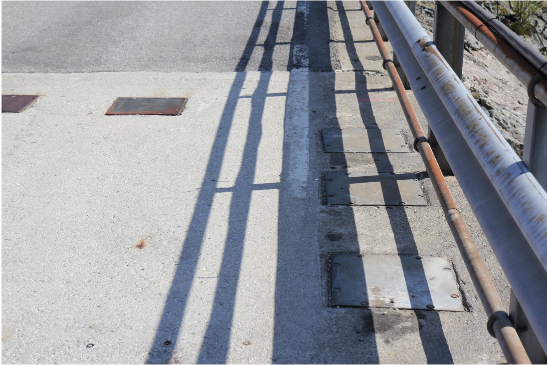
Figur 6.13: Inspeksjonsluke til fjellforankring
