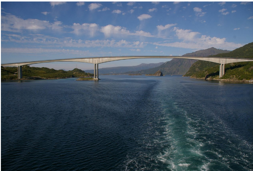
Figur 2.1: Fotografi av Raftsundet bru [8]
