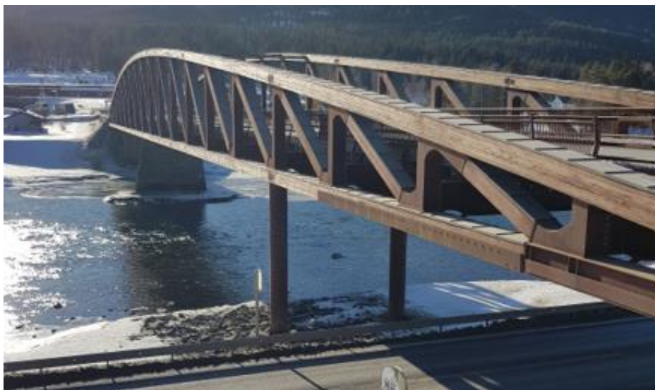
Figur 2.3 – Fagverksbru over Lågen – Foto: Rune Iversen
