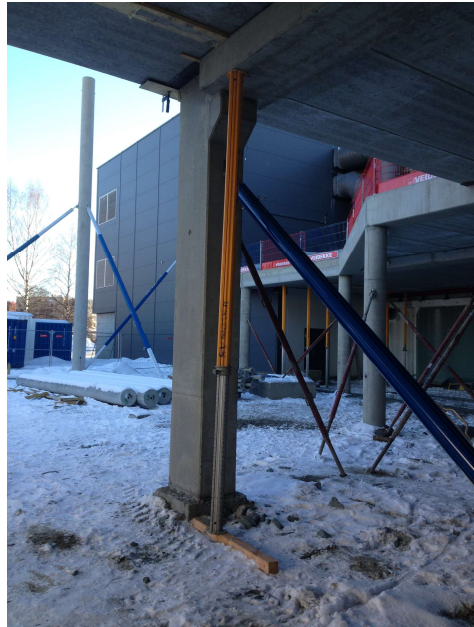
Figur 4.1: Understøttelse av en DLB-bjelke
