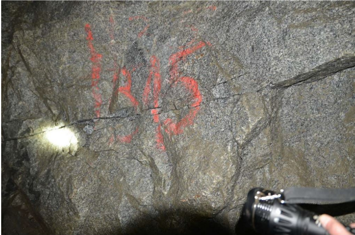
Figur C.7: Diskontinuerlig og hakkete sprekkeoverflate og sprekkeåpning opptil 1 cm ved pr. 315 (venstre vegg, motstrøms) (Jacobsen, 2016).
