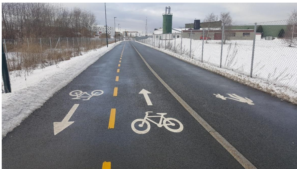
Bilde 1 Foto av den ferdigstilte strekningen mellom Rotvoll og Leangen, langs den planlagte sykkelekspressvegen mellom Ranheim og Trondheim Sentrum. Bildet er tatt 30.01.18
