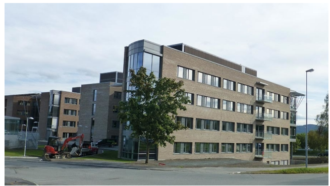
Figur 4.4: Den nye delen av kontorbygget, hentet fra Mursystem AS [38]
