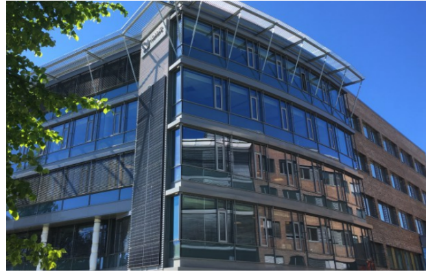
Figur 4.6: Solcellepanel montert på vegg, hentet fra prosjektoppgave ved institutt for energi- og prosessteknikk [40]
