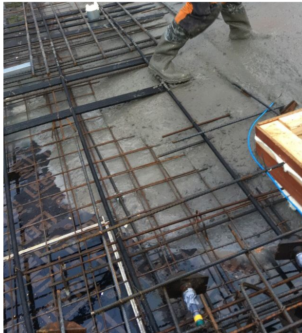
Figur 3.1: Dekkestøp, Powerhouse Brattørkaia [Foto: Anders Raastad Elgen]
