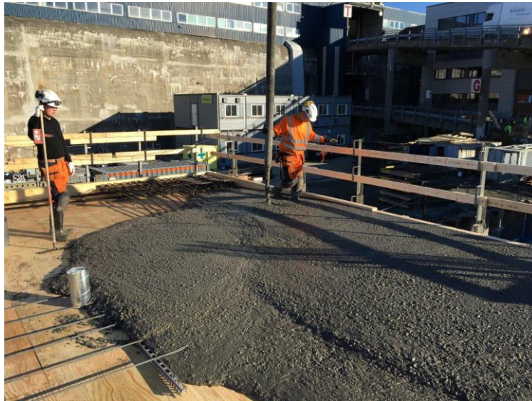
Figur 37: Støping av et spennarmert dekke [7].
