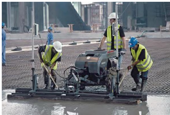
Figur 34: Avtrekking av betong med balansert laserstyrt avtrekker på hjul [8].
