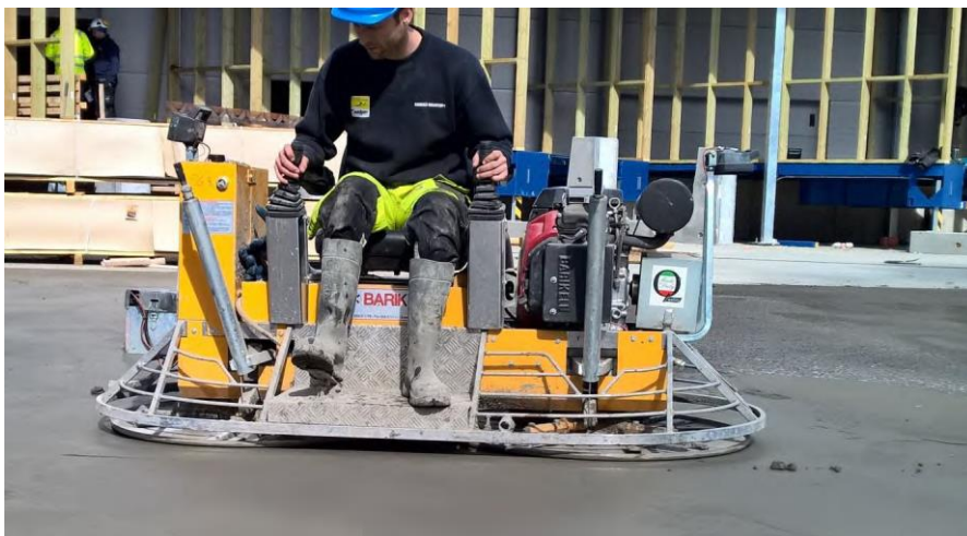
Figur 38: Brettskuring med dobbelmaskin [8].
