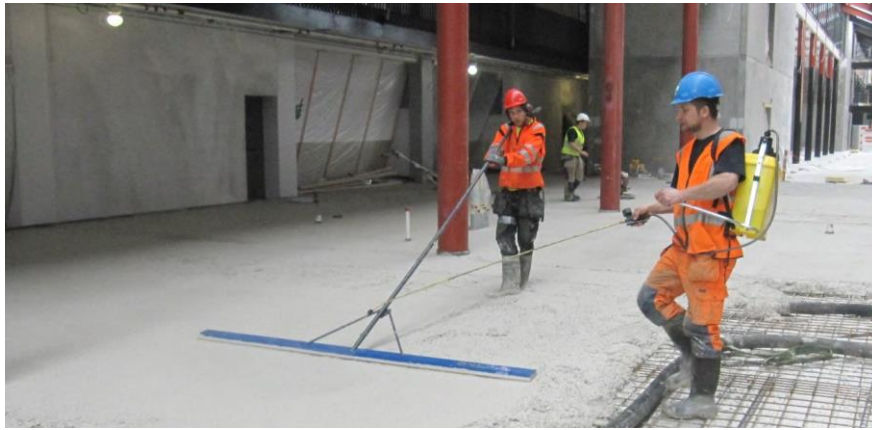
Figur 30: Avretting av betonggulv med dissestav og påføring av herdemembran [8].
