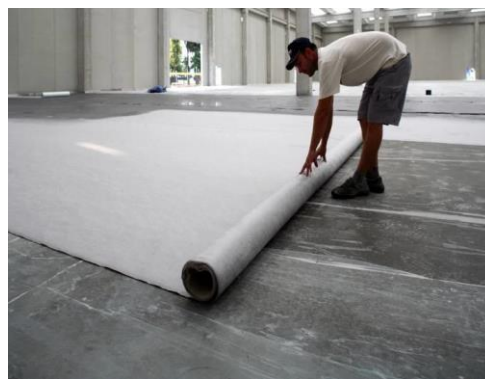
Figur 44: Utlekking av fiberduk [34].
