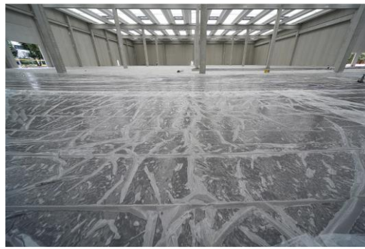
Figur 43: Tildekking av betonggulvet med plastfolie [34].
