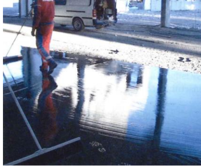
Figur 41: Påføring av vannglass (silikatbasert impregnering) [1].
