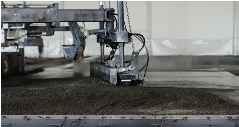
Figur 36: Avretting av betongen pågår nærmest, og strøing av tørrstoff til hardbetongen pågår lengst bak [46].
