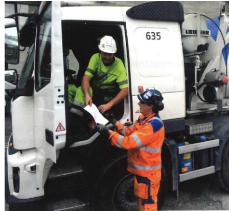
Figur 28: Signering av kontrollseddel fra betongleverandør [1].
