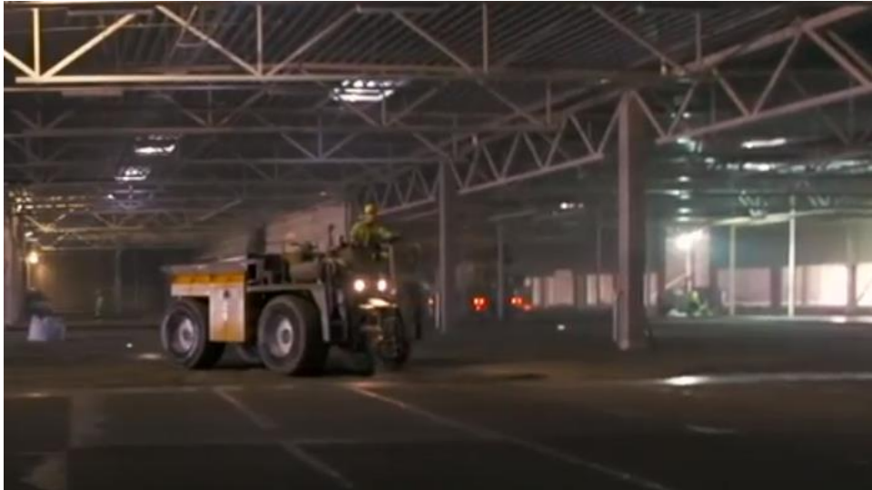
Figur 35: Utlegging av betong med dumperbil [45].
