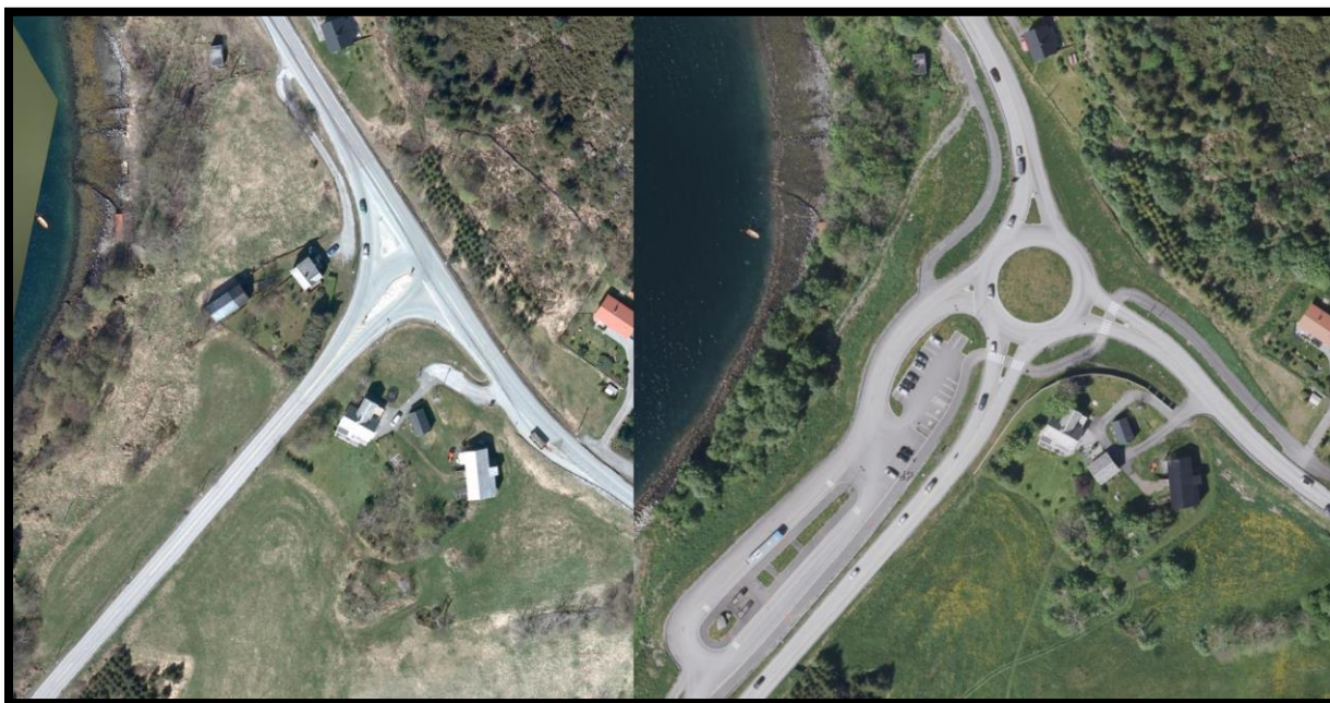
Figur 25 Garneskrysset før og etter ombygging(foto hentet fra kart.finn.no)
