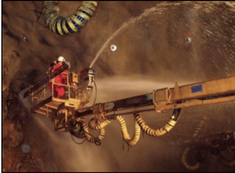
Figur 6.1: Eksempel på boring i fjell med borerigg. Vann blir brukt til fjerning av finmateriale fra borhullet, samt til nedkjøling av maskinelt utstyr. Fra Weideborg et al. (2009).
