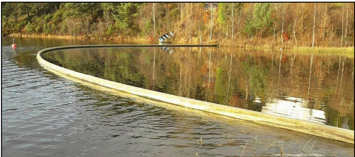
Figur 9.14: Siltgardin installert nordøst i Ulvenvatnet (Teinevika) ved utløpet av bekken fra Sveгатjørn. Online logger vises til venstre i bildet, om lag 6 m utenfor siltgardin. Bildet er tatt fra punkt for vannprøvetaking, i retning mot Sveгатjørn. (Foto: Sunniva Lunestad, 15. november 2017).
