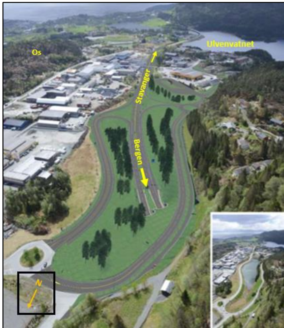
Figur 9.8: Oversiktsbilde med inntegnet ferdig veianlegg sett fra innløpet til Skogafjellstunnelen. Svegatjørn er her fylt igjen. Området før påbegynt veianlegg er vist i høyre hjørne. Utfylling av Svegatjørn er da ikke utført. Modifisert etter Statens vegvesen (2017a), målestokk var ikke inkludert i original figur.
