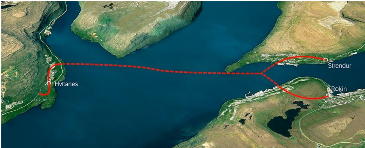
Figur 3.1: Tunnelløpet for Eysturøyartunnelen. Hentet fra P/F Eystur- og Sandoyartunlar (2018).
