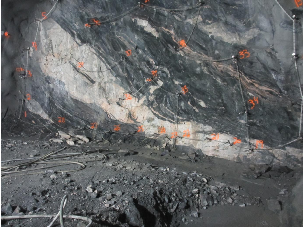
Figur 2.5: Pågående injeksjon ved Lyshorntunnelen.
