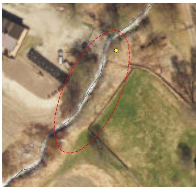
Figur 5-24: Mulig spor etter utvasking nedenfor øverste skadepunkt (Ortofoto: Norgebilder.no, juni 2017).
