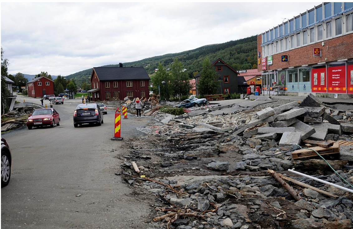
Figur 10: Vanmassene førte til store ødeleggelser i Ålen sentrum. Bildet er tatt utenfor dagligvarebutikken og viser ødeleggelser på både infrastruktur og kjøretøy. Bildet er tatt fem dager etter flomnatta. Foto: Nils Kåre Nesvold.
