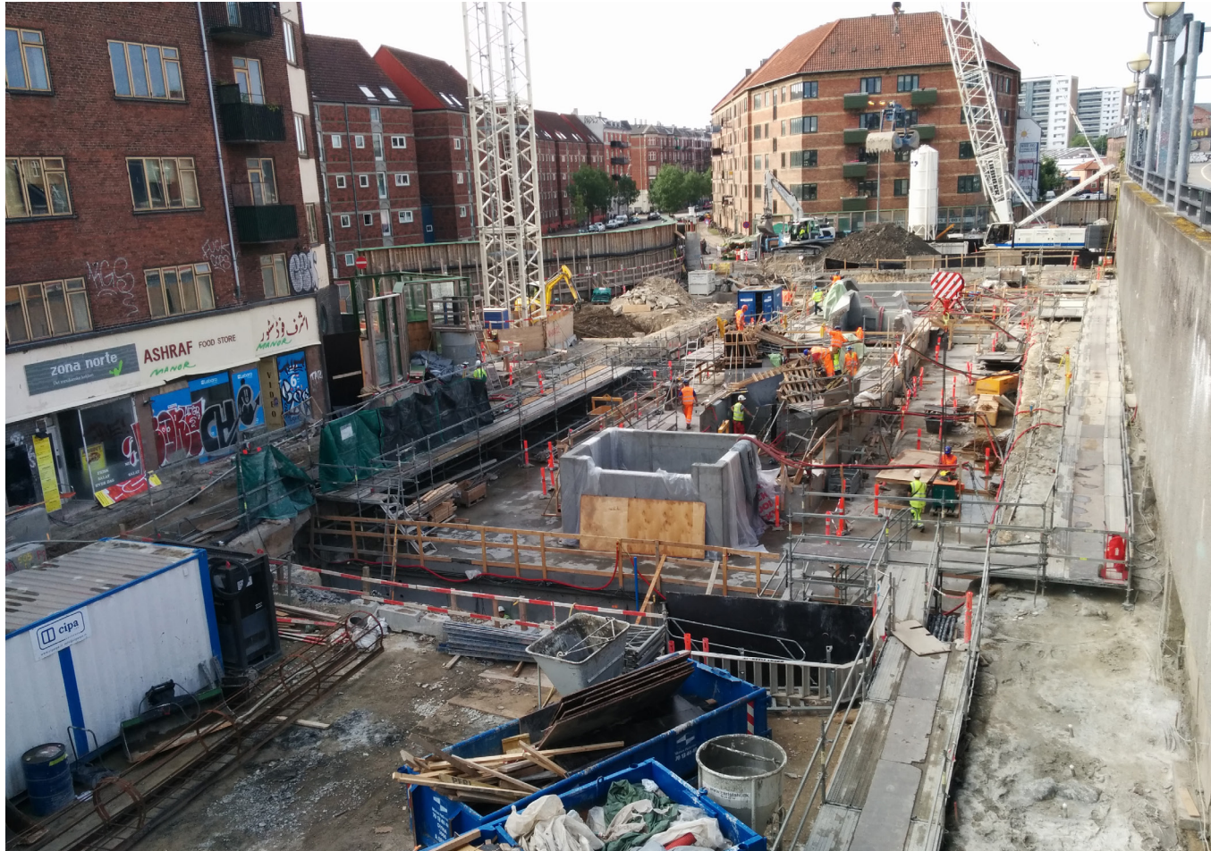
Bilde av utgravingen av Nørreport Station i København. Danmarks mangel på grunnfjell gjør at samtlige undergrunnsstasjoner i byen må bygges på denne måten.
