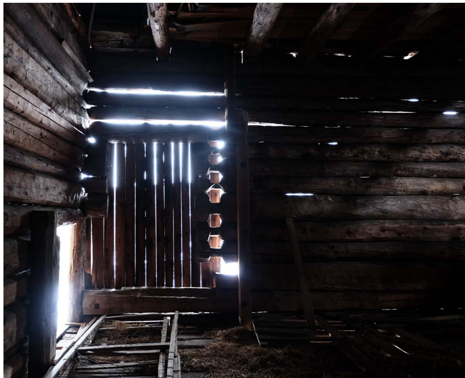
Spor etter gammel konstruksjon i kornløa
