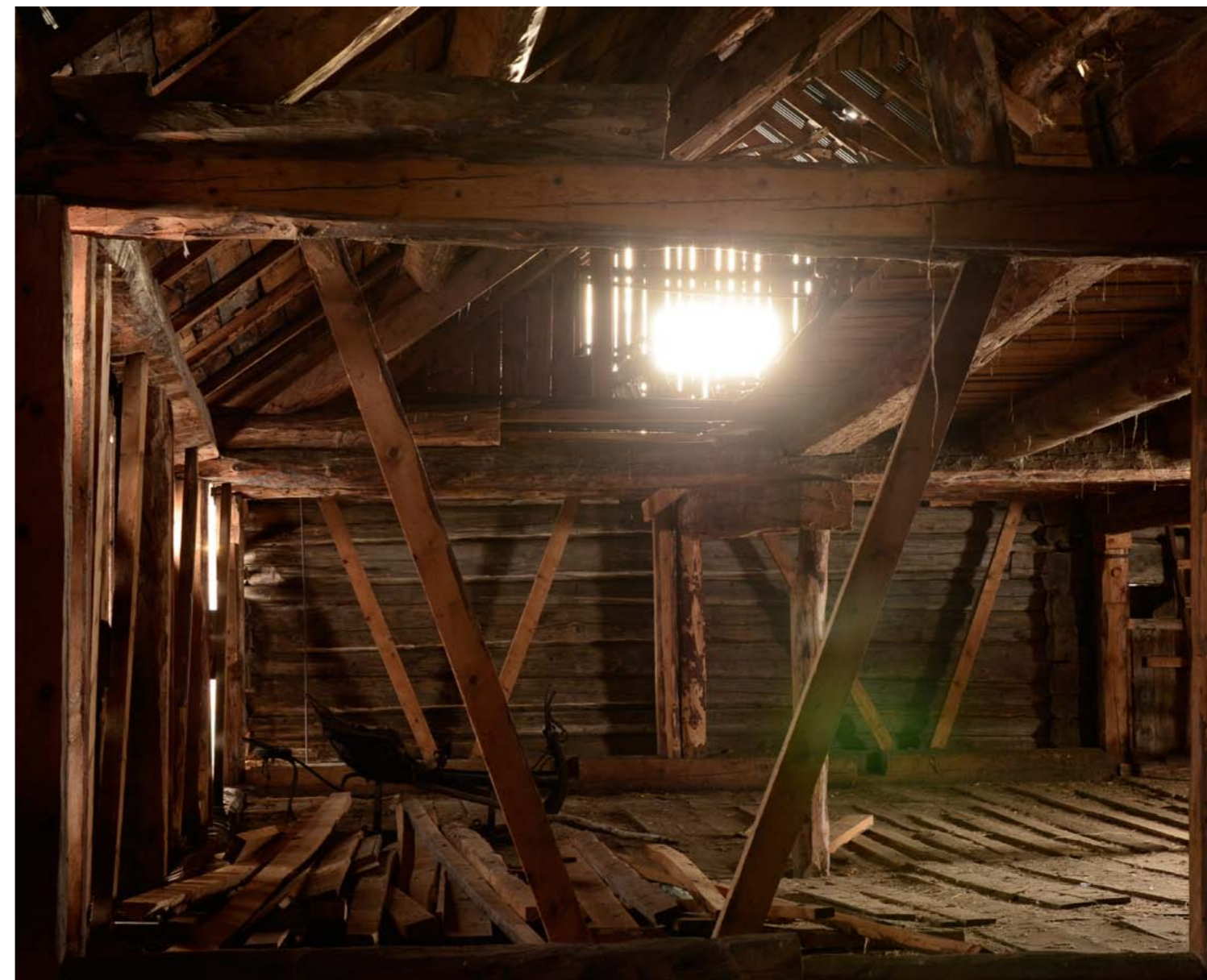
Bildet viser høyloftet med lettere grindkonstruksjon og lysinnsipp mellom panelet.
