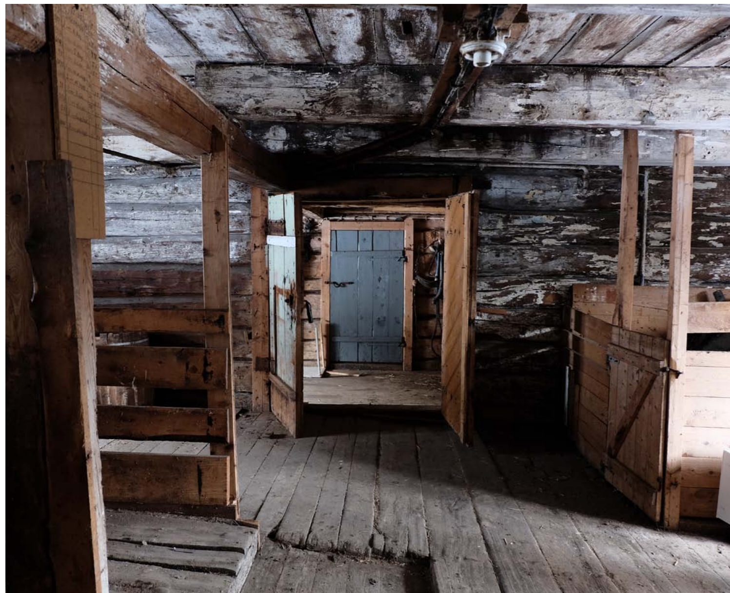
Bilde fra fjøset med sin tette, tunge laftekonstruksjon.
