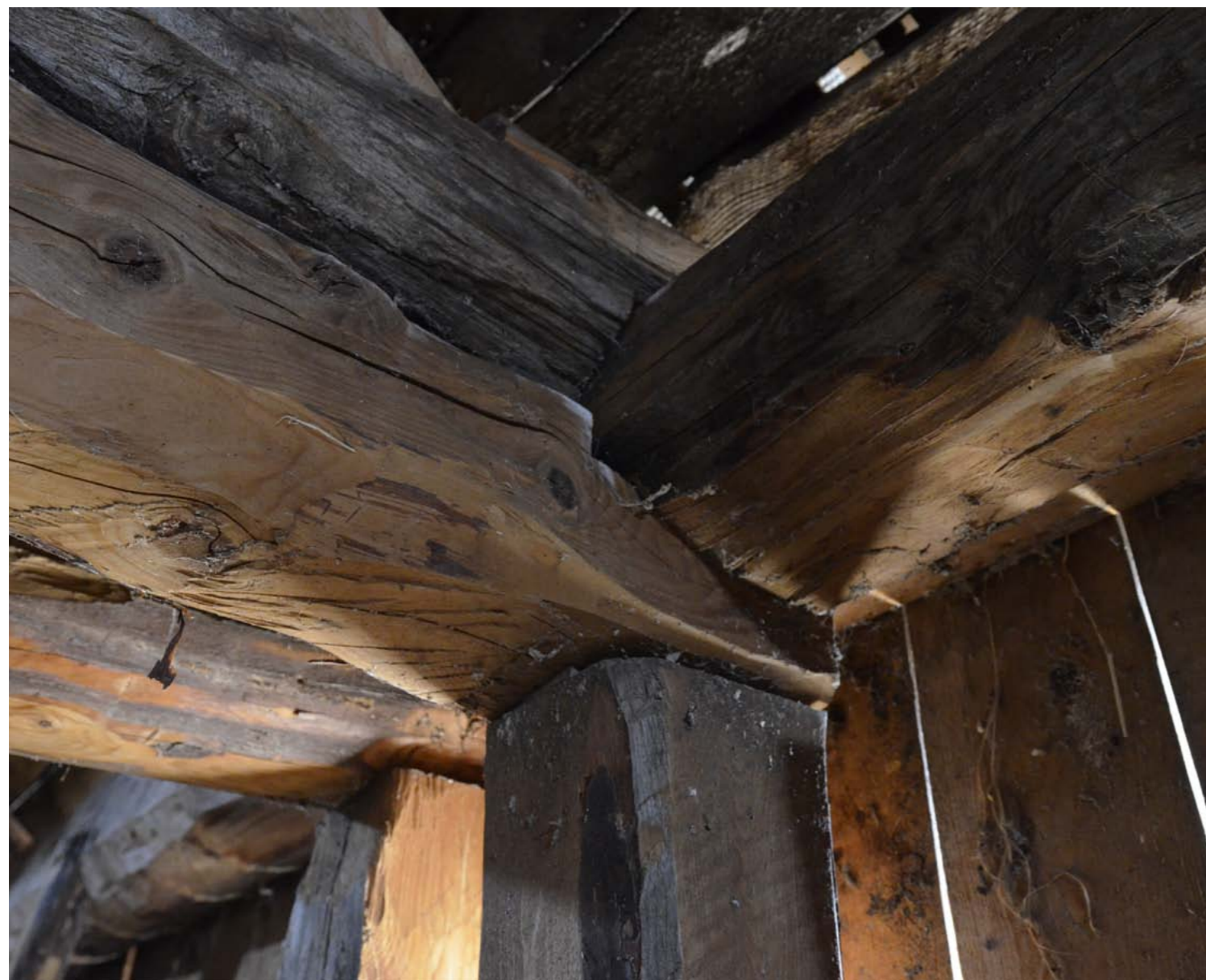
Sammenføyning av stolpe, raftstokk og tverrlinje.
