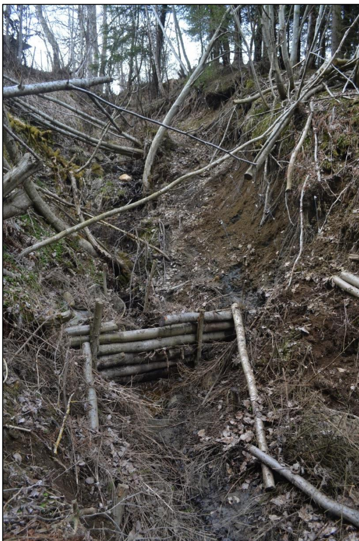
Figur 89: Stokkdam 2, samt forholdene oppstrøms stokkdammen (Økland, 03.05.2016)
