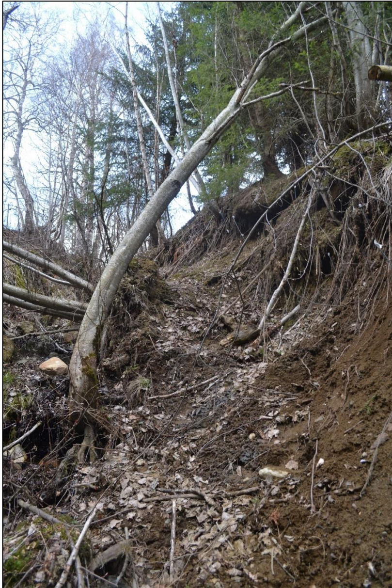
Figur 74: Høyre skråningsside. I forgrunnen ser vi et tre som ser ut til å være i ferd med å miste kontakten med substratet. Bak dette treet ser vi en liten gruppe trær som har veltet. (Økland, 03.05.2016)
