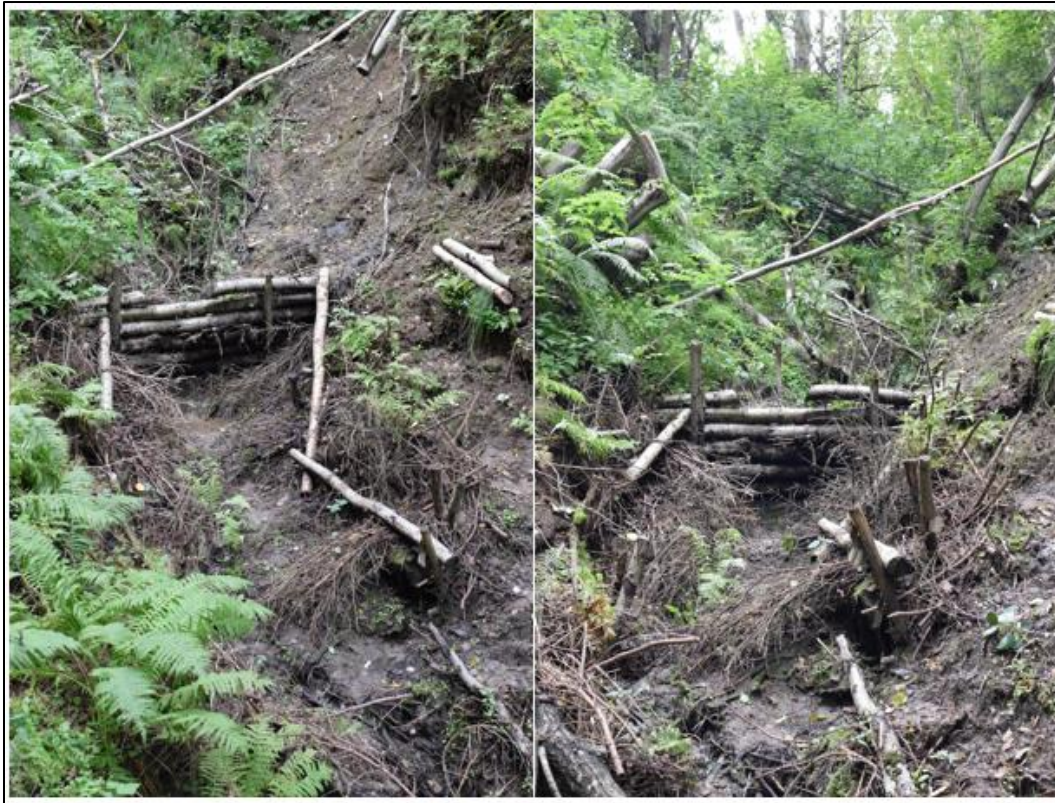
Figur 5: Vegetasjon i Engan (Stokkdam 2 er midt i bildene) (Økland, 29.08.2016)
