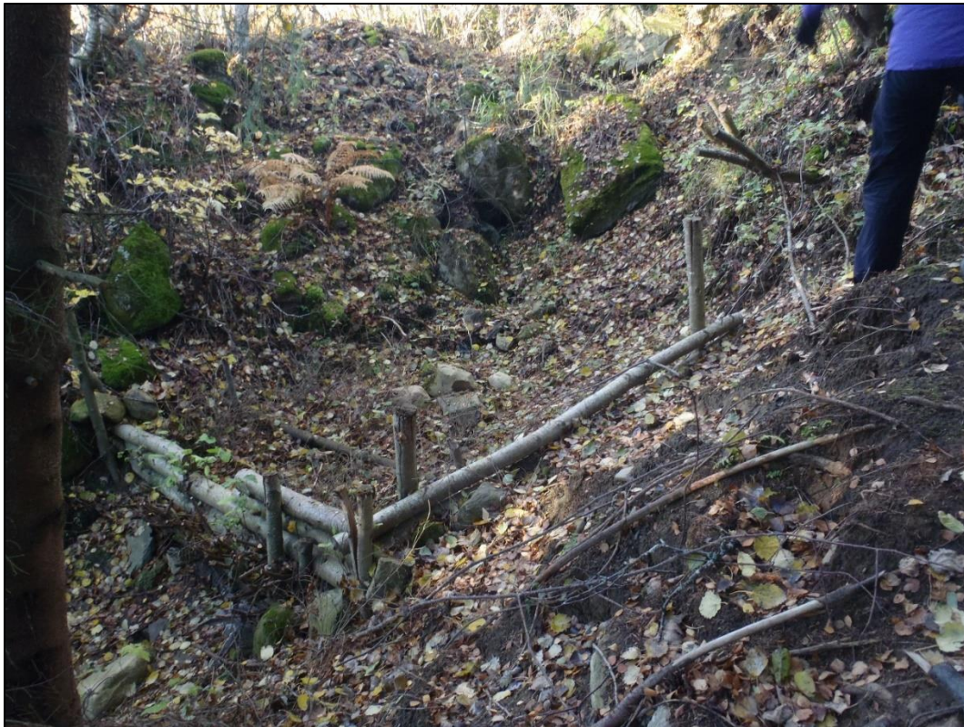
Figur 86: Steiner i begynnelsen av ravinen, samt stokkdam 1 (Trøstaker, 29.10.2015)
