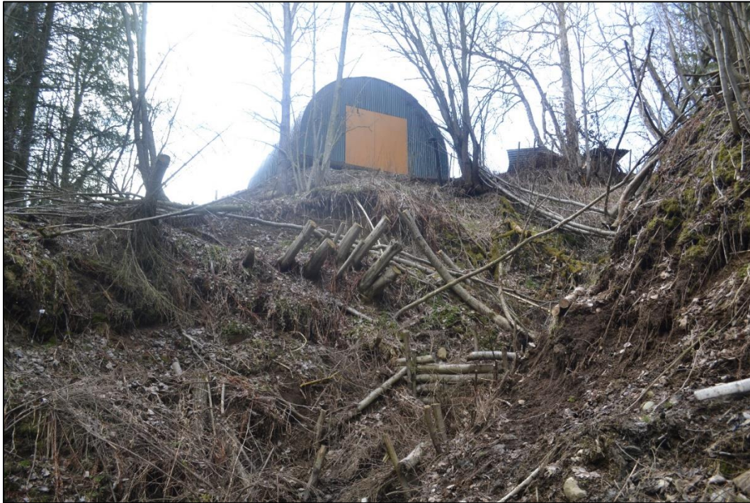
Figur 77: Antakeligvis trær som har blitt benyttet i konstruksjonen av stokkdammene (Økland, 03.05.2016)
