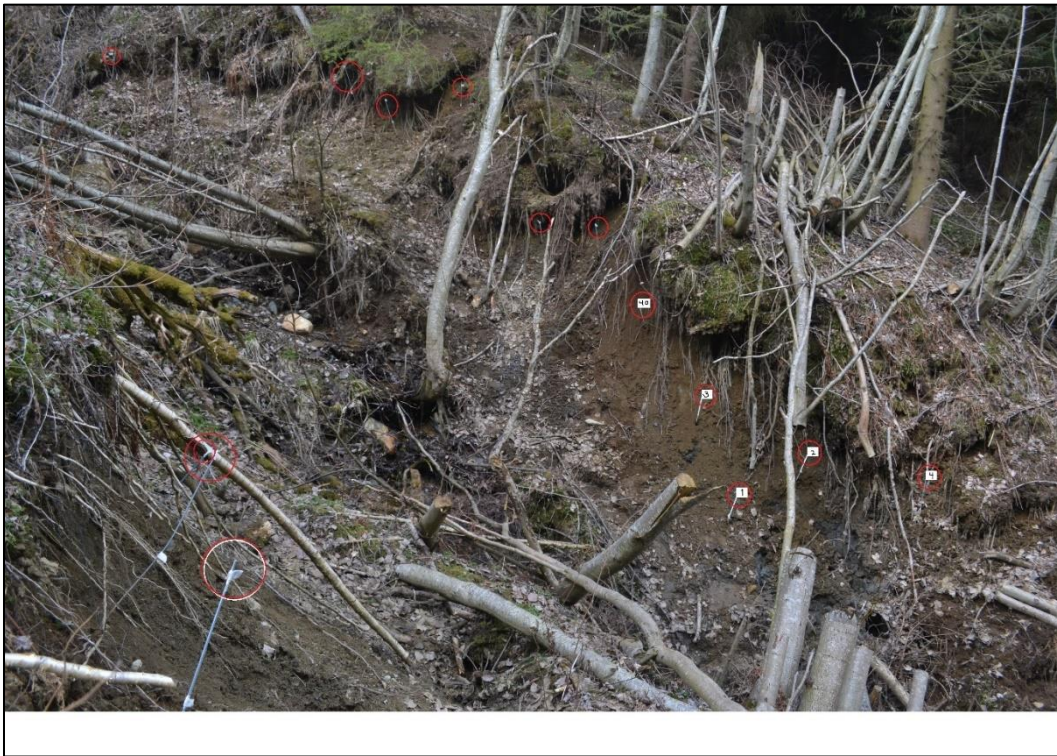
Figur 19: Punkter, høyre skråningsside (punkt 40, 3, 1, 2 og 4 er merket av med hvite felter), Økland, 03.05.2016
