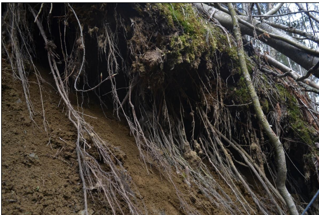
Figur 95: Underkutting og porøse løsmasser, høyre skråningsside (Økland, 03.05.2016)
