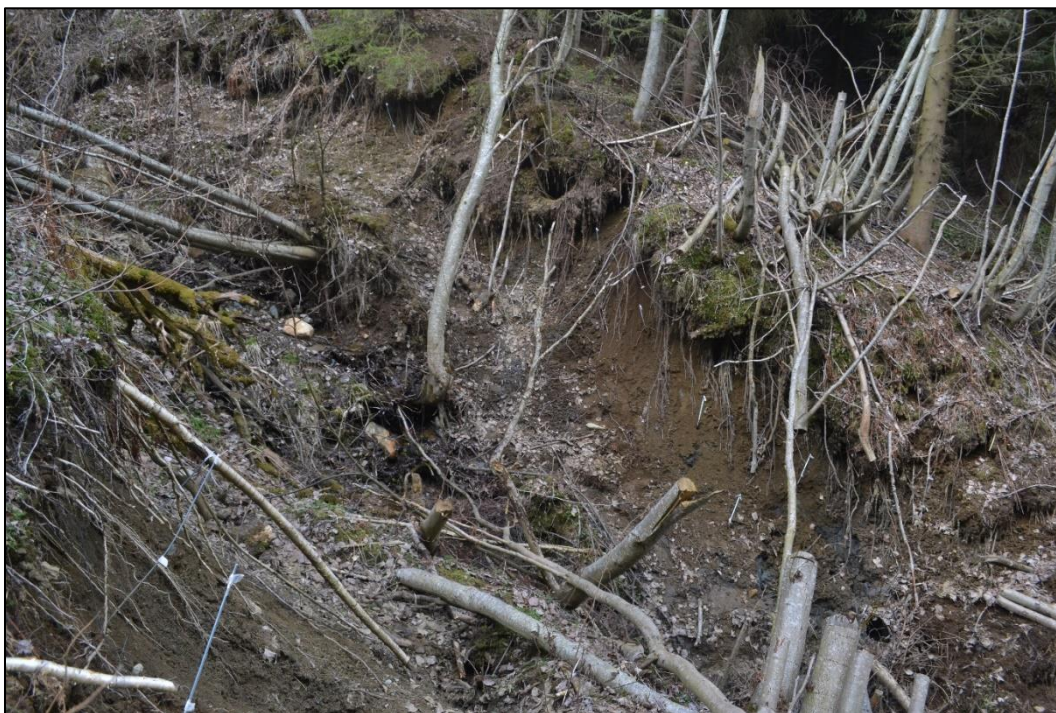
Figur 61: Forsøk på å illustrere ulikheter i skråningsgradienter i ravinen (Økland, 03.05.2016)
