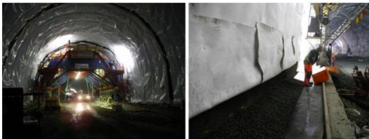
Figur 9: Installasjon av foliemembran og drenerende filtduk i Ulvintunnelen(jernbanetunnel).(Holter, 2017b)
