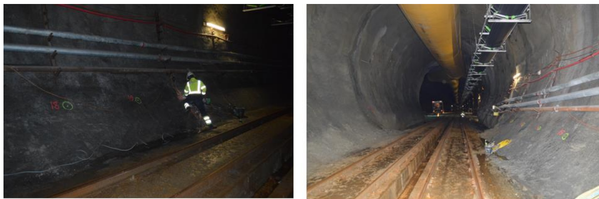
Figur 24: Venstre: Kjerneuttak på Arna siden. Høyre: Tunnelløpet sett i retning mot Arna med sprengt del lengst unna.
