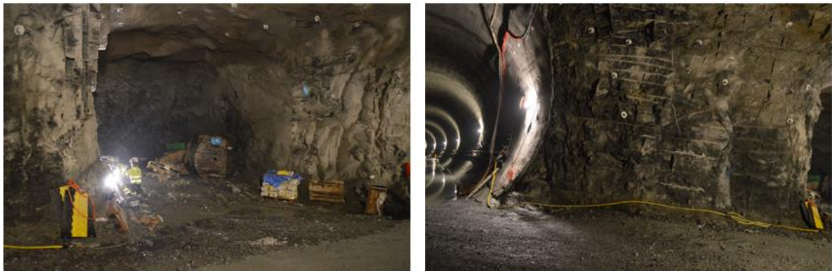
Figur 26: Bildet til venstre: Nisje hvor borkjerne 1-5 ble tatt ut for Fløen-siden. Kjernene ble tatt på venstre side av nisjen. Bildet til høyre: Plassering av nisje (lengst til høyre) i tverrslaget i forhold til tunneløpet drevet med TBM som kan ses til venstre i bildet.
