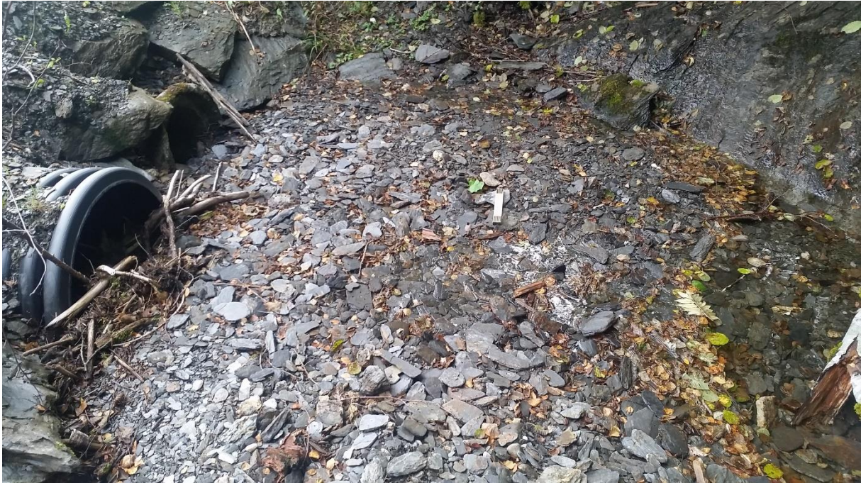
Figur 56: Eksempel på større stikkrenner oppdaga i felt. Begge har blitt kraftig tetta i front med ein kombinasjon av planterestar og fyltitt, noko som sannsynlegvis har skjedd over lengre tid. Fyltitten fyller opp heile oppstraumsområde, og har sannsynlegvis opphav i ei nærliggande bergskjeringa. Bildet er tatt ved punkt 031, mot sørvest (Dato: 13.09.2017).
