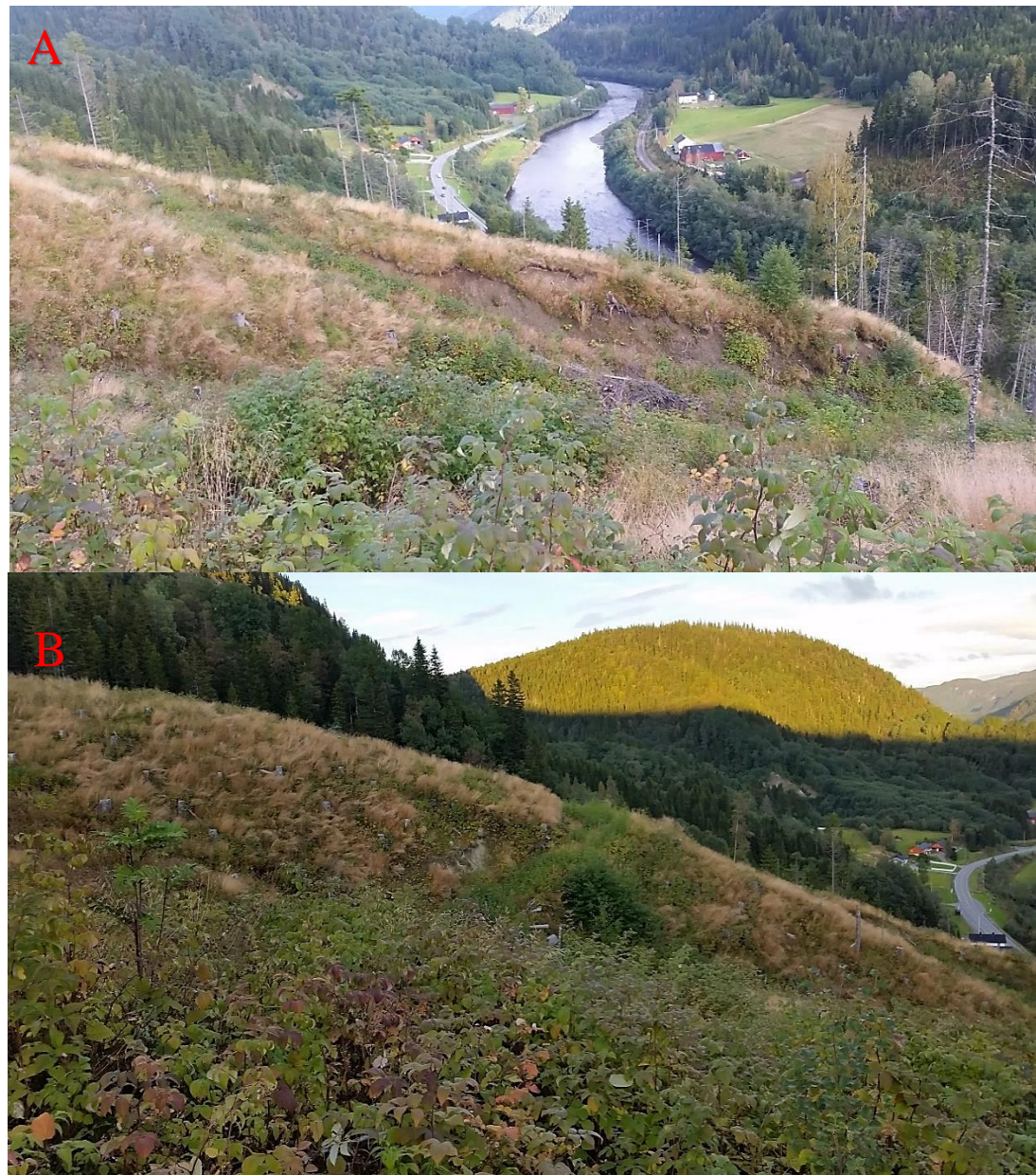
Figur 44: Avstandsbilde av marine avsetningar i feltområdet. Øvre bilde (A) viser utgliding langs tidlegare driftsveg i denne materialtypen, og avsløre eit gråbrunt lag under. Mektigheita verkar til å vere på fleire meter, basert på høgda av åsen der utgliding har skjedd. Nedre bilde (B) viser ei skjering i terrenget som vart danna under skogdrift, og avdekkar tydeleg grå massar. Bilda er tatt nær GPS punkt 029 og 030, i respektivt aust-søraustleg og nordaustleg retning (Dato:
