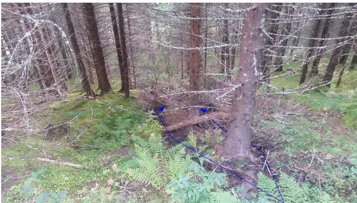
Figur 52: Ferske bekkefar i skog nær GPS 041. Vatn drenera frå erosjonssporet observert i Figur 51 , og fortsette ned ei steinlagt forseinking før det går i desse kanalane. Blå piler viser kva retning vatnet strøymar. Som ein ser, så har vatnet erodert seg forbi to større grantre, og fortsette nedover terrenget mot hovudvegen til feltområdet. Bildet er tatt mot Ø-SØ (14.09.2017).
