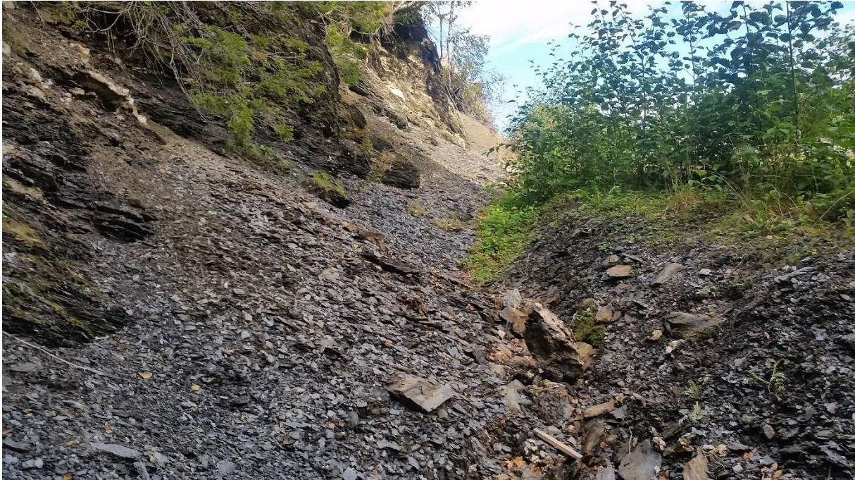
Figur 57: Grøft i nærleiken av stikkrenne vist i Figur 56 . Fyllitt frå nærliggande bergeksponeeringar har forvitra over tid og fylt opp grøftene med lausmassar, derav redusert deira tverrsnitt og gitt grunnlag for seinare massestraum ved erosjon. Delar av jorddekke over eksponeeringa har og rast ut over tid, noko ein kan observere ved brunfargen langs skiferen til venstre i bildet, samt utrasinga av lokal morene i det fjerne. Bildet er tatt ved punkt 031, i austleg retning (Dato:13.09.2017).
