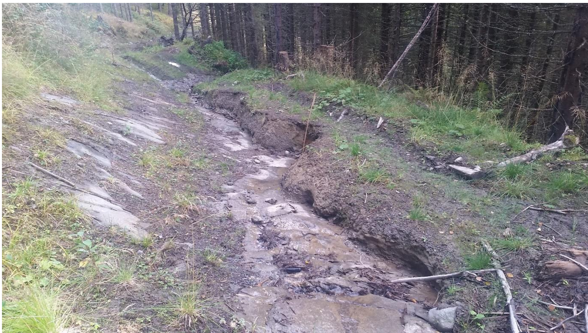
Figur 51: Større erosjon av driftsveg i sørlege delar av feltområdet. Vestre del av vegen er meir eller mindre vekkerodert ned til grunnfjell, med eit djup på maksimalt 52 cm (Målestokk i bilde breitta ut til 100 cm). Usikkert korvidt erosjon har pågått over lang eller kort tid, men den verkar å vere aktiv då forfattar fann rennande vatn i mindre mengder langs grunnfjellet. Vegmassane verkar til å bestå av lokal morene, og er underlagt av gråvakke. Bildet er tatt mot NØ, ved GPS punkt 040 (14.09.2017).
