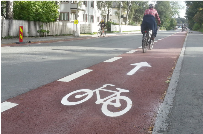
Sykkelfelt i Klæbuveien
