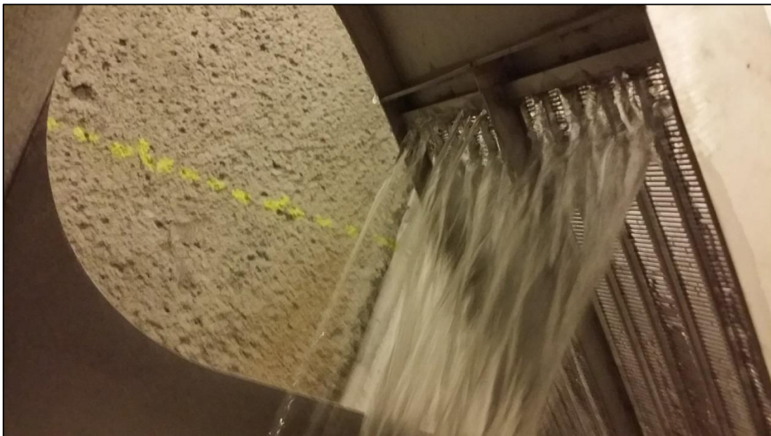
Figur 27 Øverste spalter delvis igjenfrosset
