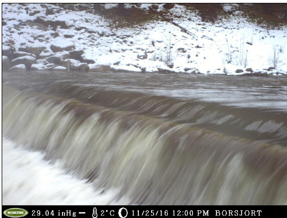
Figur 18 Flom ved inntaket 25.11.16
