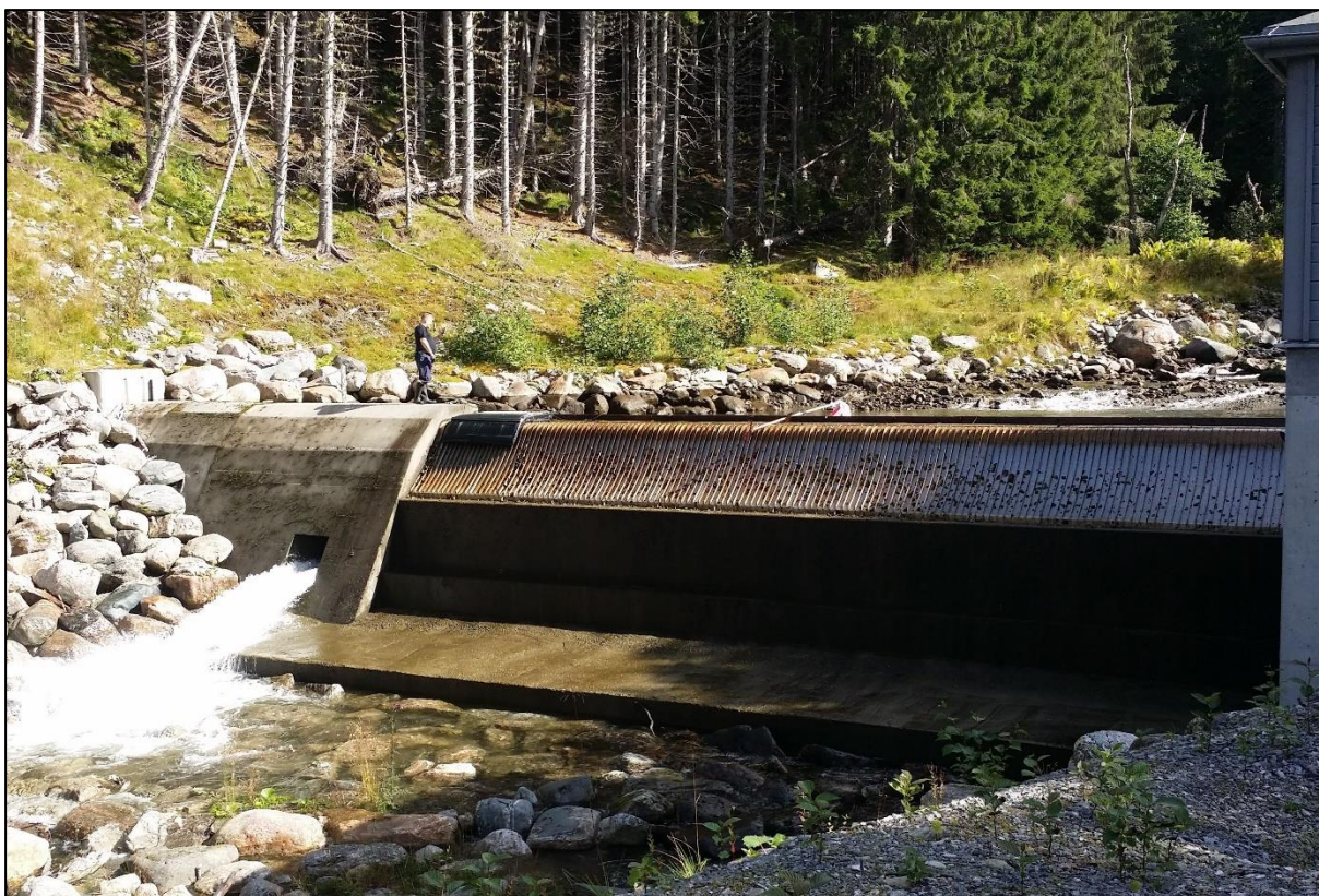
Figur 4 Dyrkorn inntak sett nedstrøms under nedtapping
