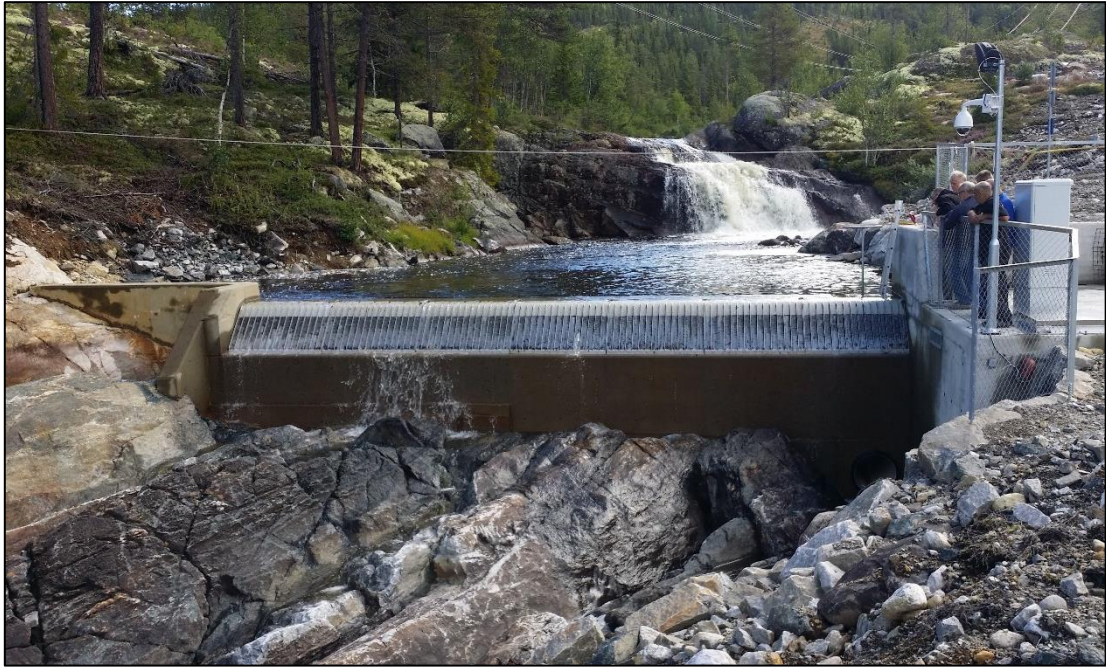
Figur 6 Oversiktsbilde av inntaket ved Tverråni
