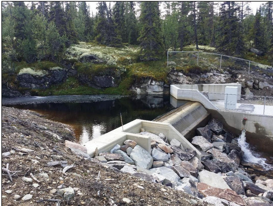
Figur 8 oversiktsbilde av inntaket ved Nybuelvi
