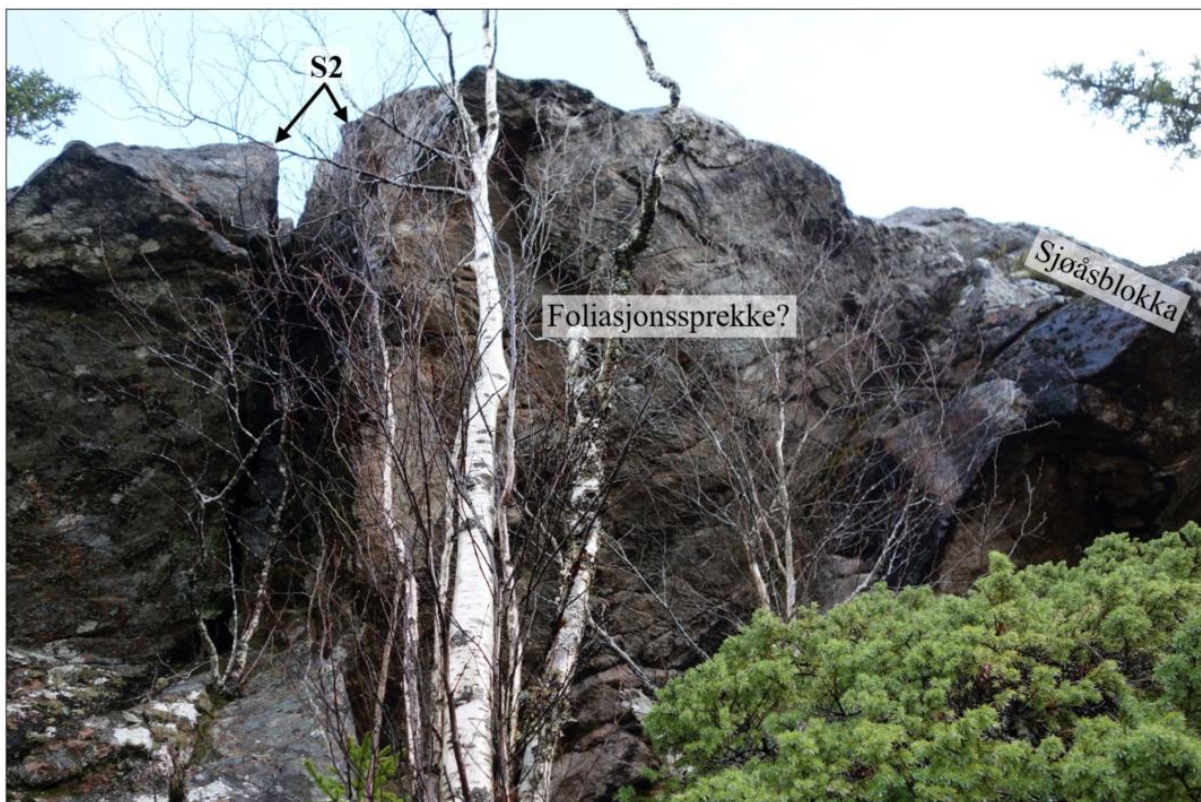
Figur 5-1. Oppe i front av Sjøåsberget der den store opne sprekkane er.
