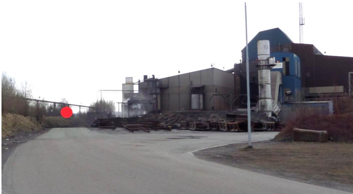
Figur 10.1 Celsa (stålverket) sett fra vest. Slaggbehandlingen foregår foran bygningen. Prøvepunkt 1006 er merket med rødt. Foto: Arnfinn Pettersen
