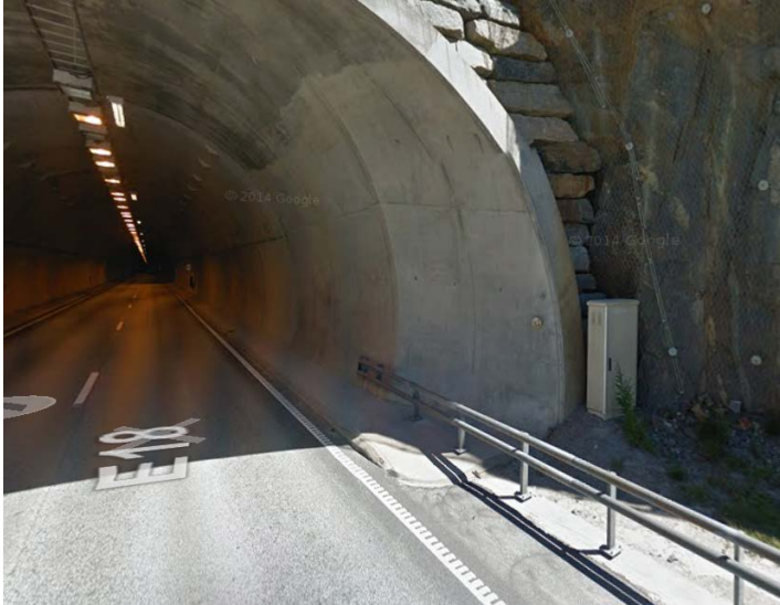
Figur XX – Bilde av bankett i tunnelmunning (E18 – Google gatebilder)
