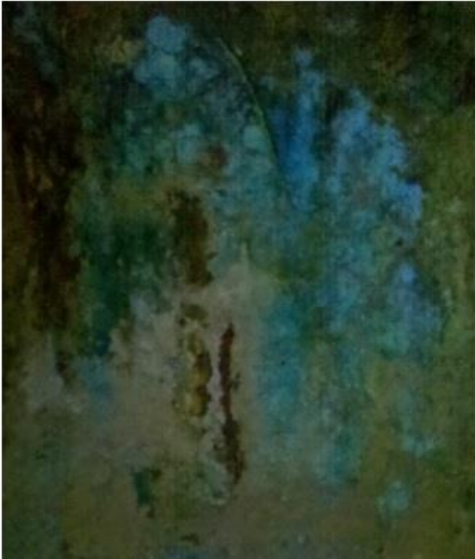
Figur 2.8. Bildet er tatt fra sjakten inn til gamlegruva til Løkken gravene. De blå flekkene på bildet er kobber som kan være på toverdige form. Slike flekker ble observert ved flere punkter langs veggene inne i gruva. Foto: CO
