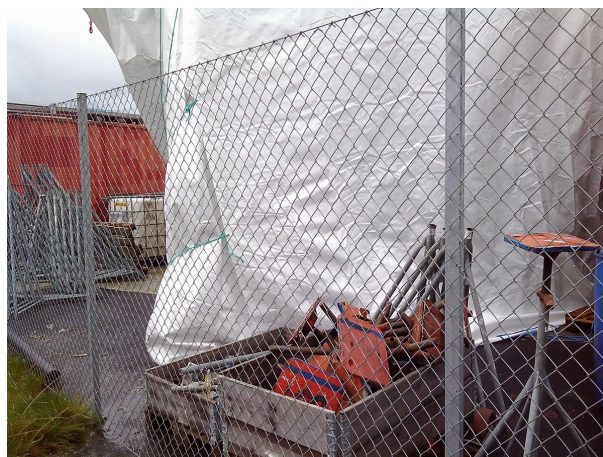
(b) Lagring av diverse utstyr ved sandfangskum 39
