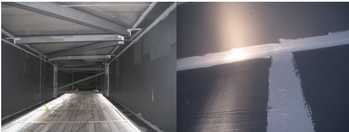
Figur 32: Lauvøystraumen, stripemalt før helstrøk med epoksymastik i 2013 (Foto: SVV)
