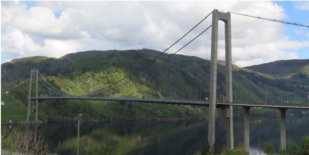
Figur 33: Osterøybrua, oversiktsbilde (Foto: Brutus/SVV)
