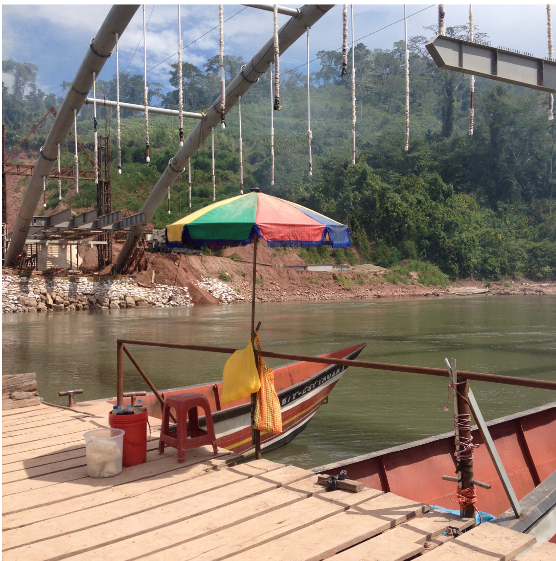
Bruen som sørget for at hovedveien samles. Den ble ferdig februar 2017.
