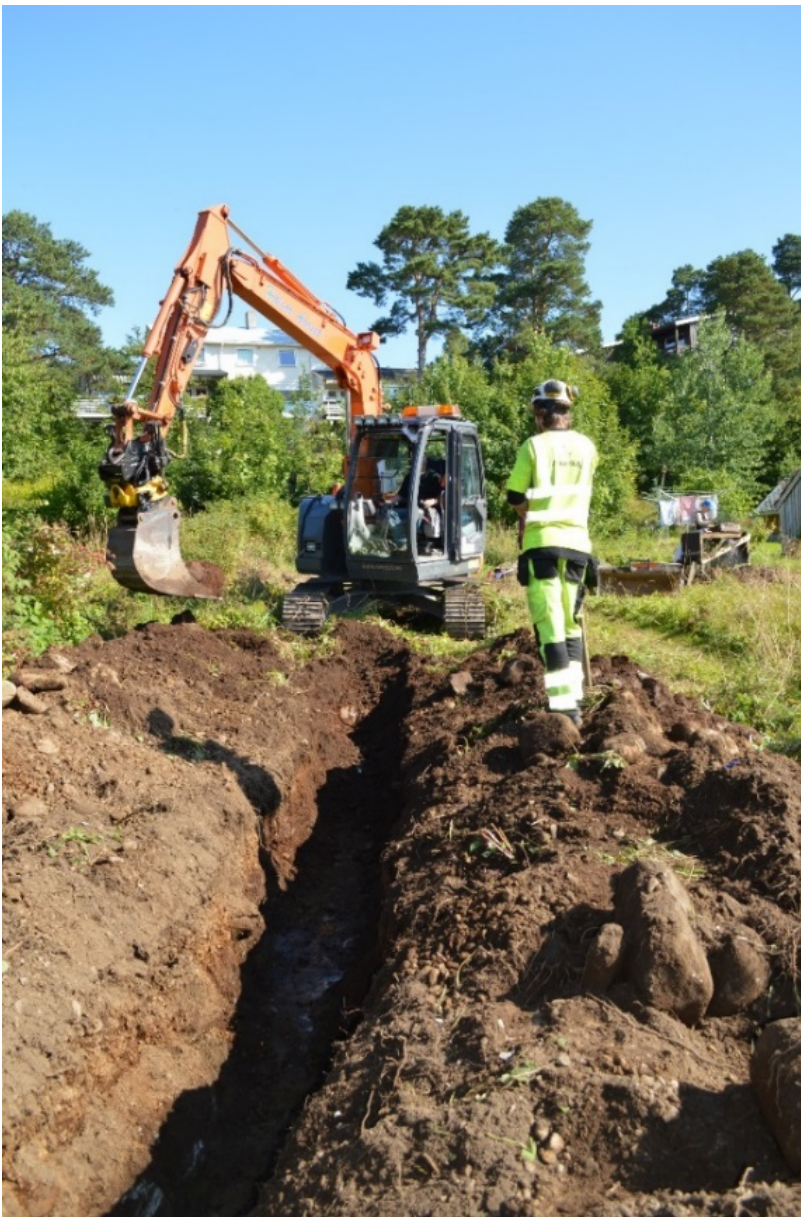
Figur 19 Arkeolog Skule Olaus Spjelkavik overvåker graving av drenggrøft. Foto: Lene V, Kirkhus, NTNU Vitenskapsmuseet. Da60618_75
