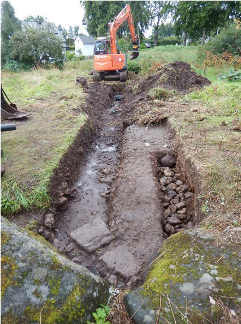
Figur 34 Dreneringssjakt. Bildet er tatt mot SV. Foto: Skule O. Spjelkavik, Møre og Romsdal fylkeskommune
