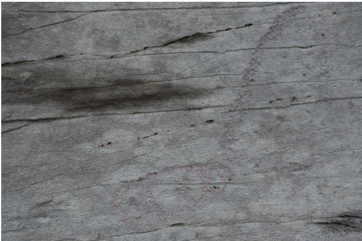
Figur 25 For denne figuren er det nok med en gjennomgang av malingsfjerningsprosessen med Gel 1 og etter-rengjøring med løsemiddelblanding, Da 62015_29
