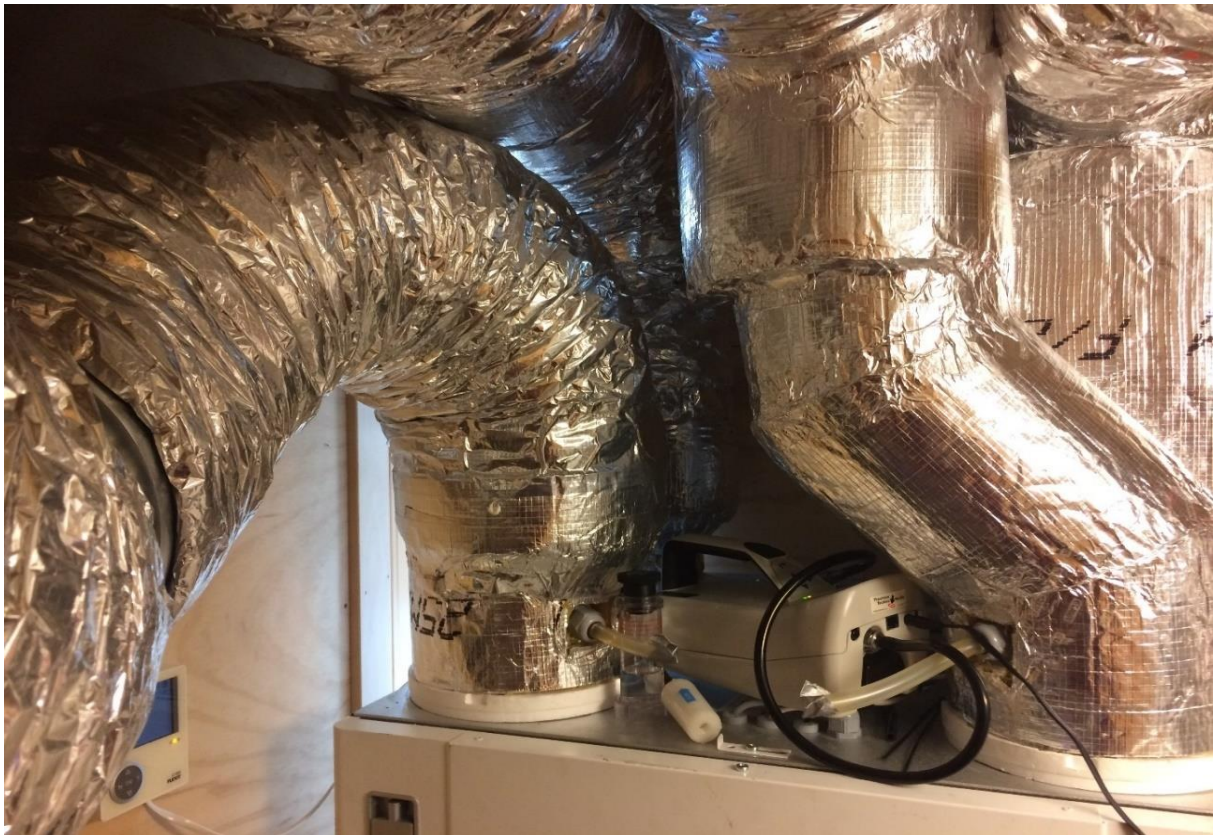
Figur 19 Måling av partikkelnivå i uteluften ved å koble apparatet til ventilasjonssystemets inntakskanal i teknisk rom (Foto: Merete Wærstad)
